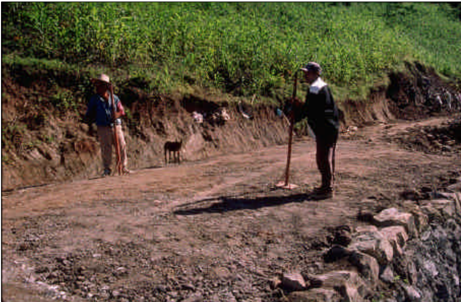
Foto 11.6 Compactación simple a mano, por detrás de un muro de roca. La compactación es importante en la parte posterior de cualquier estructura de contención o de un relleno.
