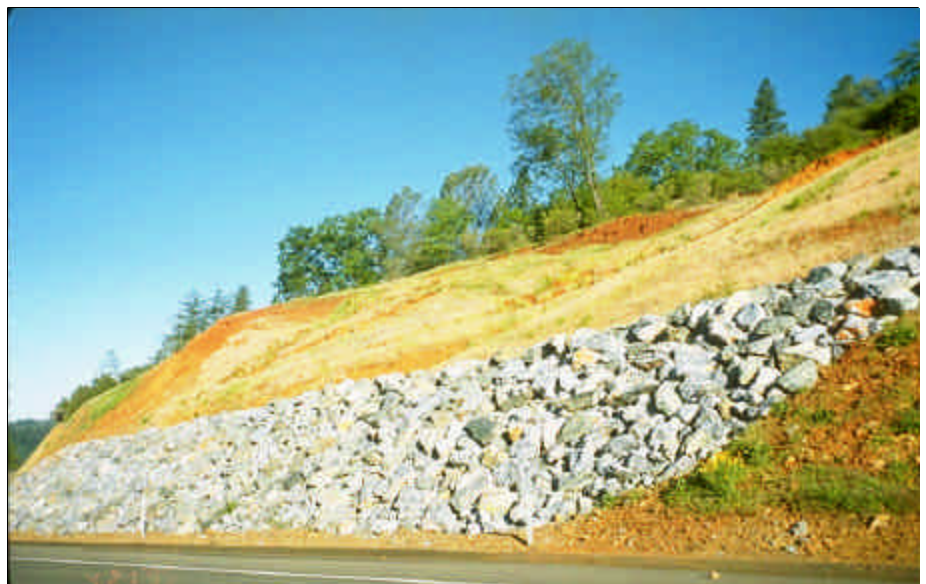
Foto 11.7 Se puede usar ocasionalmente un contrafuerte de roca permeable para estabilizar una zona de falla de talud en un corte.
