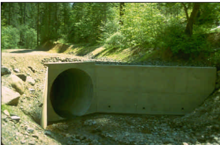
Foto 8.7 Use estructuras con el cauce natural como fondo, tales como arcos sin fondo, alcantarillas de cajones de concreto o tuberías en arco colocadas por debajo de la elevación del fondo del arroyo, para promover la migración de peces y minimizar los impactos al arroyo.
