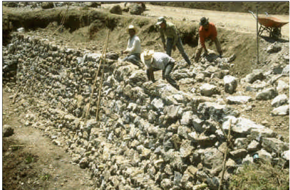
Foto 11.8 Aplique métodos de estabilización física de taludes, tales como muros de contención, rellenos reforzados o contrafuertes de roca en caso necesario, en zonas con limitaciones de espacio o laderas muy pronunciadas.
