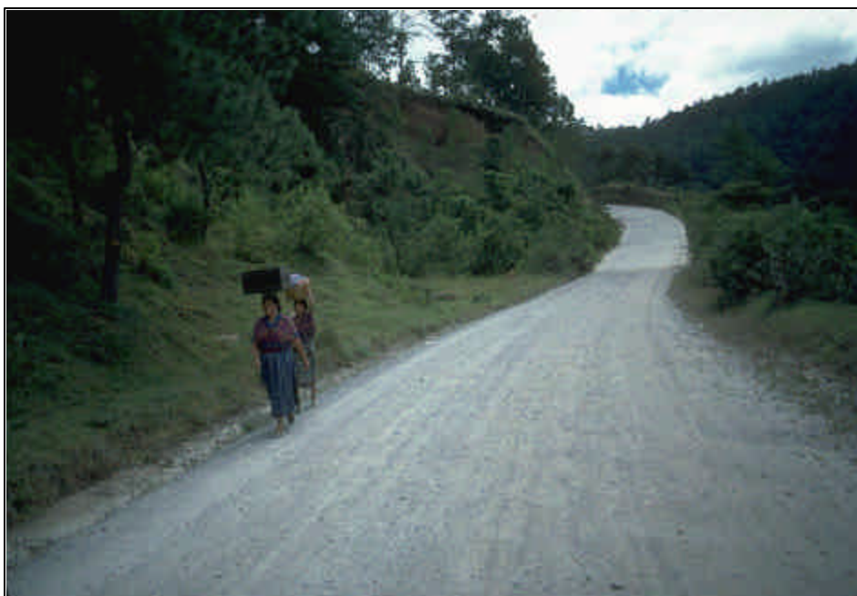
Foto 1.1 Un camino con impacto mínimo que está bien drenado, tiene una superficie estable de rodamiento, terraplenes estables, y es satisfactorio para el usuario.
