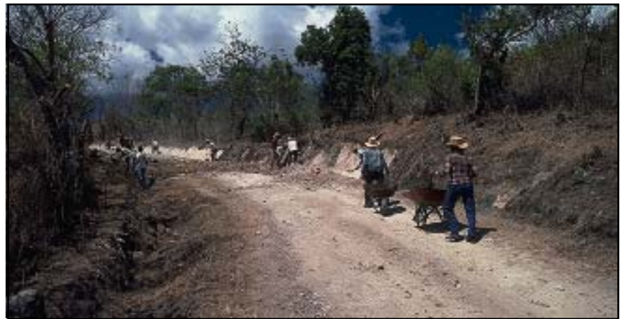
Foto 4.7 Aplique las técnicas de construcción de caminos que sean más redituables en cuanto a costo para el proyecto y el área geográfica en particular. La comparación de la mano de obra contra el uso de equipo depende de los costos, la disponibilidad del equipo y las tasas de producción.
