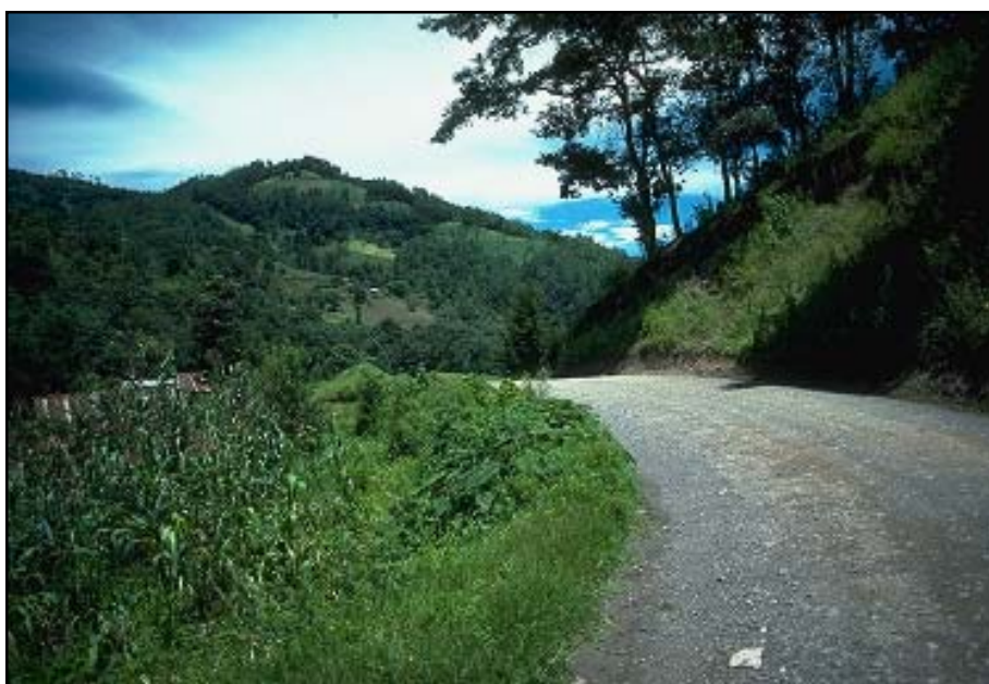
Foto 2.5 Camino bien diseñado de “impacto mínimo”, que tiene una especificación adecuada para su uso, buen drenaje y taludes estables.
