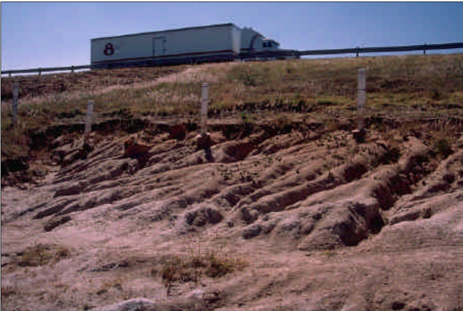
Foto 13.2 Erosión producida en un talud adyacente a una carretera, debida a la falta de vegetación o a un inadecuado de uso del suelo. Observe que la vegetación está evitando la erosión junto a la carretera.
