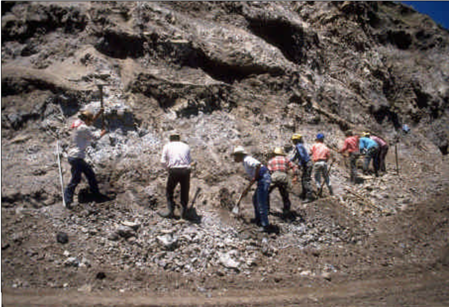
Foto 12.9 Explote pedreras y bancos de préstamo (fuentes de abastecimiento de materiales) cercanos al sitio del proyecto, siempre que esto sea posible. Puede resultar adecuado hacerlo a mano o con máquinas, dependiendo de las condiciones del sitio y del ritmo de producción.
