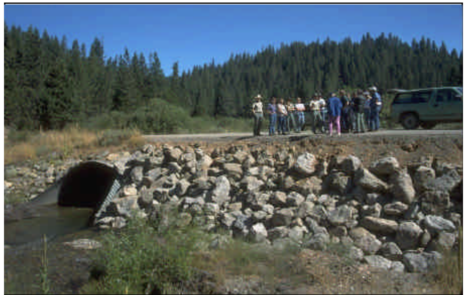
Foto 8.4 Alcantarilla tipo arco con placa estructural, con protección de las márgenes del arroyo a base de enrocamiento de gran tamaño, colocado sobre una capa de filtro de geotextil.
