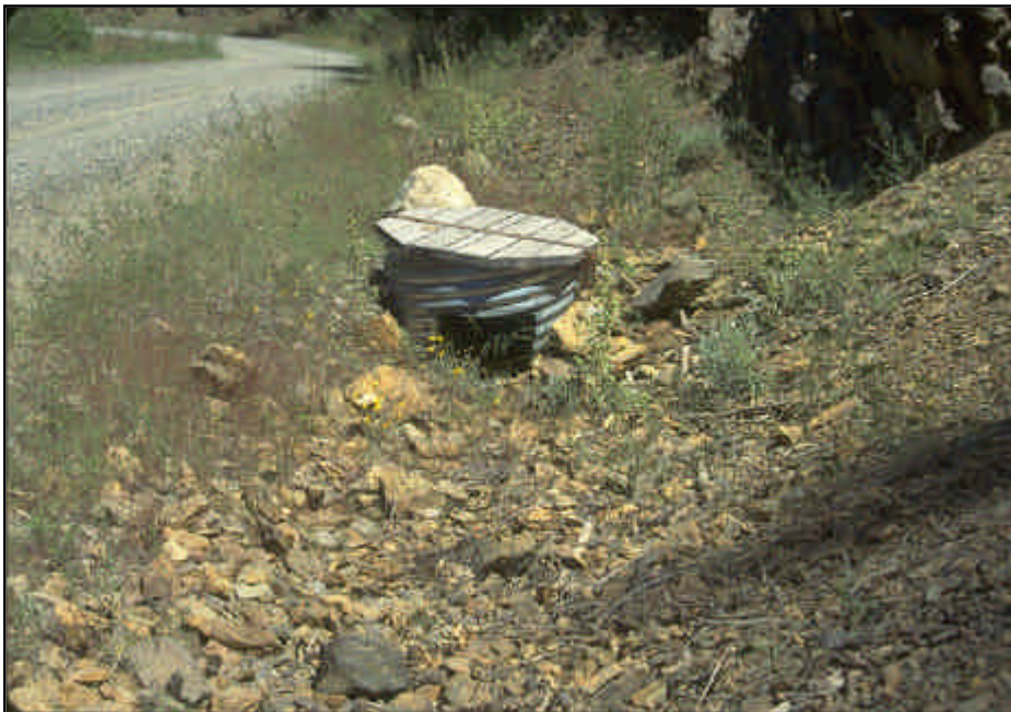
Foto 7.7 Cuneta protegida con enrocamiento y boca de caída para controlar el agua y evitar la socavación de la cuneta.
