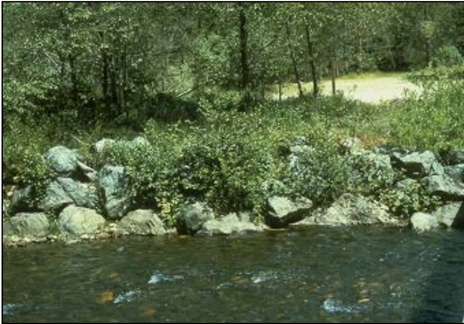
Foto 6.2 Enrocamiento usado para la protección de márgenes del arroyo contra la socavación a la entrada de una estructura. Observe el empleo de sauces para aumentar la resistencia “biotécnica” derivada de las raíces.
