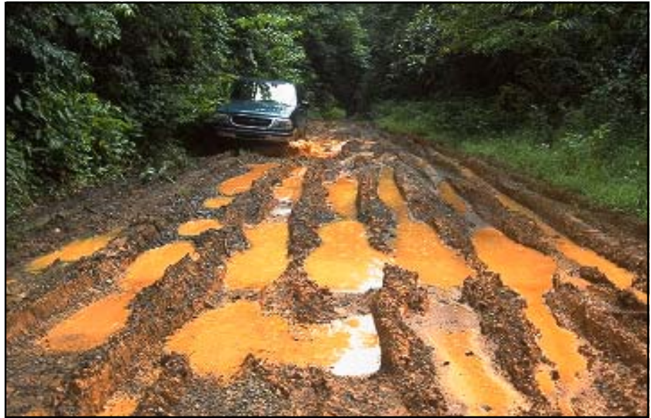
Foto 4.8 Evite las actividades de construcción y de otro tipo durante las temporadas de lluvia siempre que sea posible. Alternativamente, añada estabilización de la superficie y del drenaje en zonas de suelos pobres, para su uso en cualquier tipo de clima.
