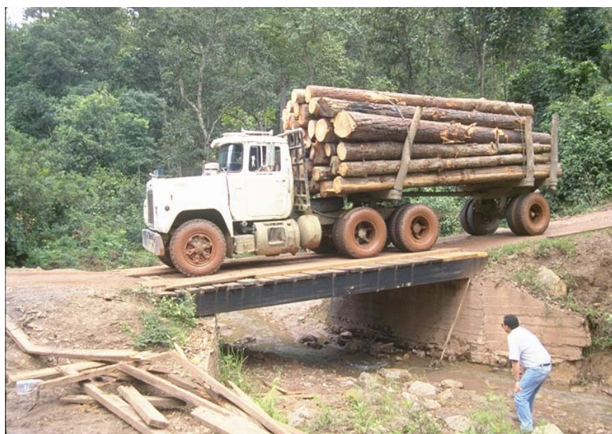
Foto 10.1 Se pueden usar alcantarillas, vados o puentes para el cruce de arroyos. Use puentes para atravesar arroyos permanentes anchos, para minimizar las alteraciones al cauce y evitar retrasos en el tránsito. Use un claro lo suficientemente ancho como para evitar la constricción del canal natural. Ubique la cimentación sobre roca sana o por debajo de la profundidad de socavación.
