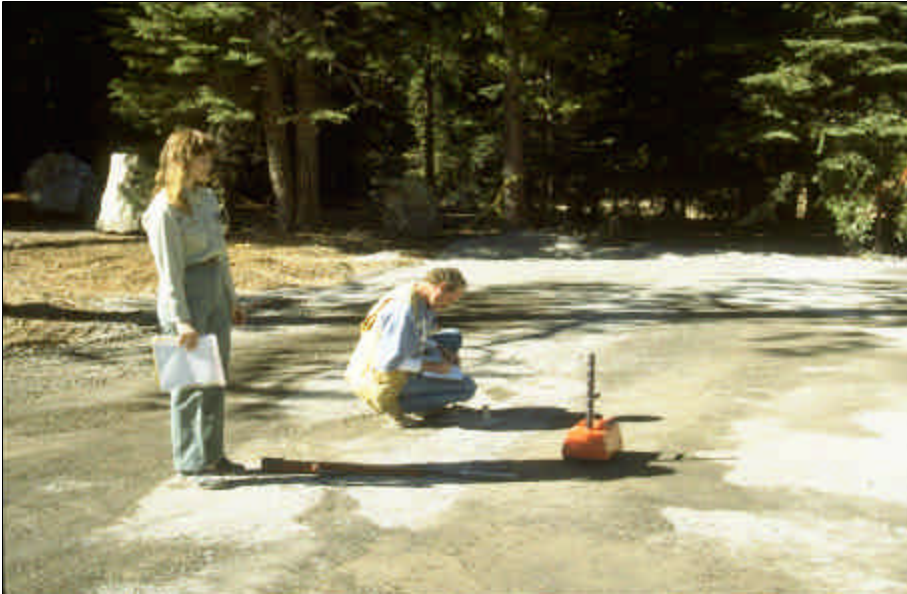
Foto 12.6 Uso de un “densímetro nuclear ” para verificar la densidad del agregado. Use control de la calidad durante la construcción, tales como pruebas de granulometría y de peso volumétrico, entre otras, para lograr las propiedades esperadas de los materiales, para el proyecto en cuestión.
