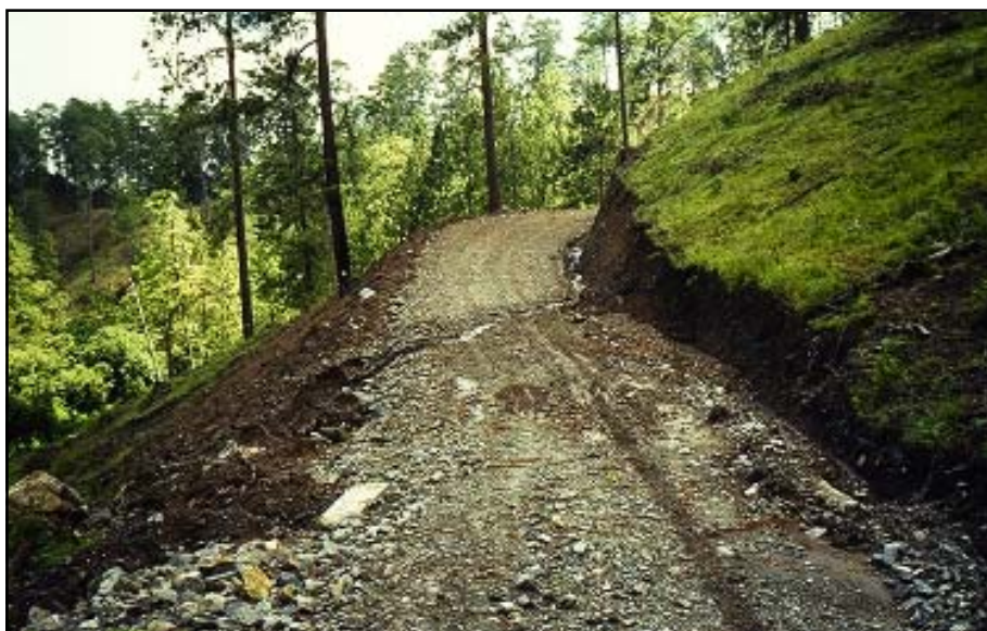
Foto 4.3 Evite la construcción de caminos con pendientes escarpadas o en laderas empinadas. Resulta difícil controlar el drenaje cuando el gradiente del camino es muy pronunciado.
