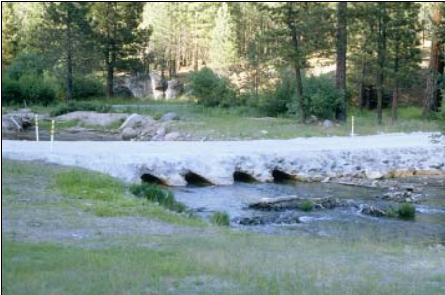
Foto 9.2 Un vado con alcantarillas, usando tubos múltiples de alcantarillas para desalojar el flujo a través de los mismos y mantener a los vehículos fuera del agua, pero que dejan pasar sobre toda la estructura las avenidas grandes y escombros.
