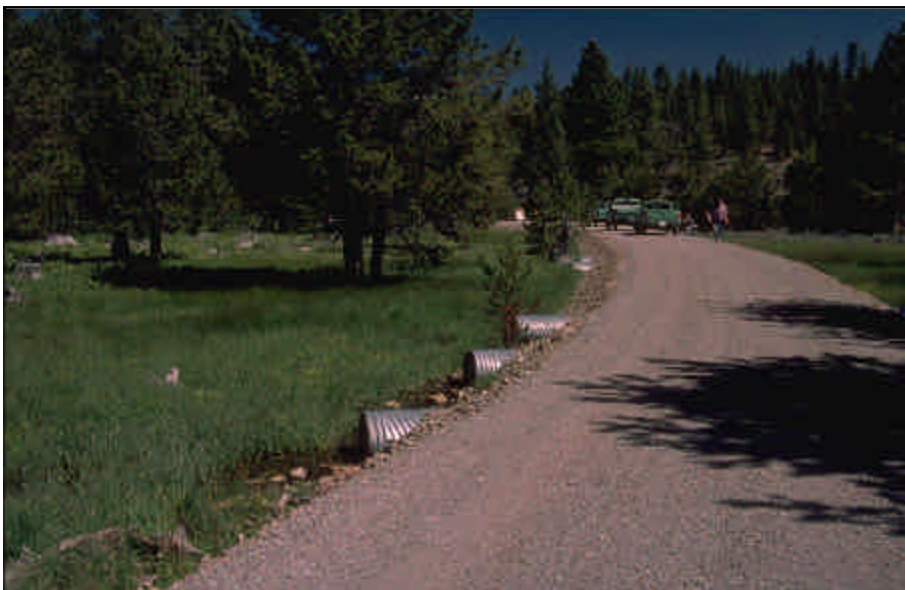
Foto 7.9 Evite el cruce de zonas de praderas inundadas. Si se tiene que cruzar, use tubos múltiples para poder dispersar el flujo de agua a través de la pradera.
