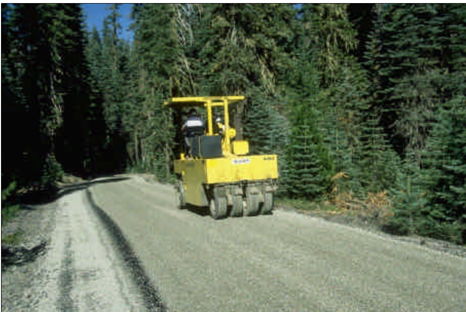
Foto 12.8 Compactación de una superficie con posterior riego de sello. Se puede usar una gran variedad de materiales de recubrimiento, dependiendo de su disponibilidad, costo y desempeño.
