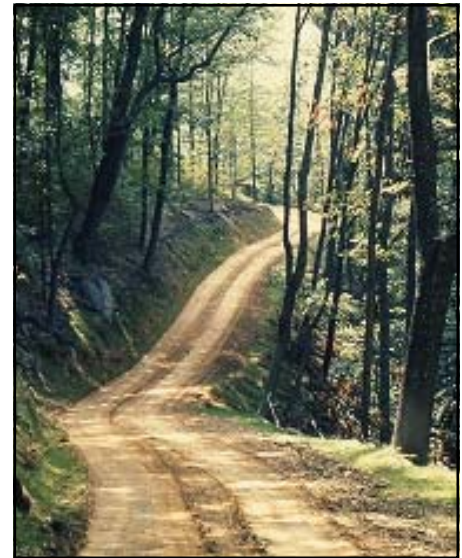
Foto 4.2 Localice los caminos de tal manera que se adapten a la configuración del terreno natural y deje ondulaciones que permitan dispersar el agua frecuentemente. calidad y la inspección , para garantizar que el trabajo se lleva a
