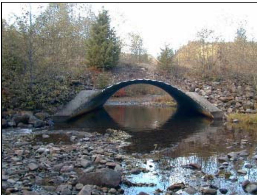
Foto 2.3 Alcantarilla en arco sin fondo que cubre la mayor parte del claro del cauce del arroyo, mantiene inalterado el fondo natural del arroyo, minimiza la afectación al sitio y ayuda a promover la migración de peces. (Foto proporcionada por S. Wilson-Musser).
