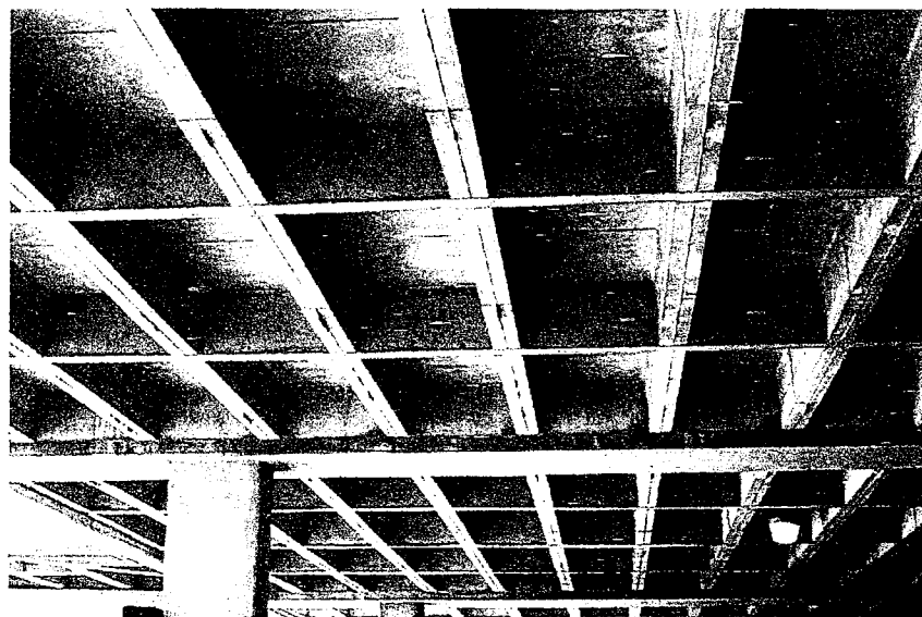
Fig. 2-2 Losa Nervada armada en una dirección.
