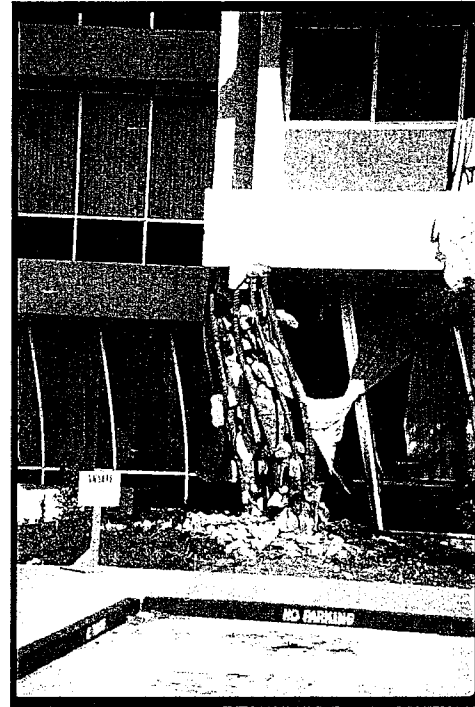
Fig. 16-10 Columna con estribos
