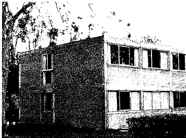
Fig. 2-15 Edificio de albañilería confinada.
