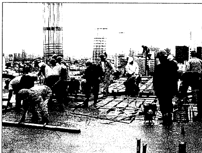
Fig. 2-3b Llenado de un aligerado. Lima
