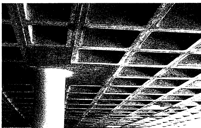
Fig. 2-6 Detalle del encuentro losa – columna (Waffle Slab)
