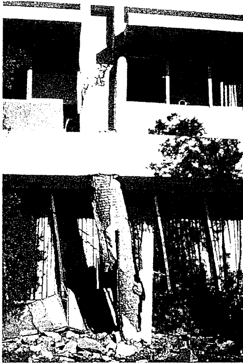
Fig. 16-9 Columna con espiral.
