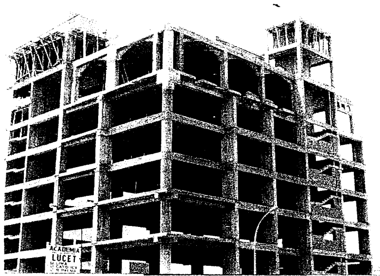
Fig. 2-17 Edificio aporcionado de concreto armado
