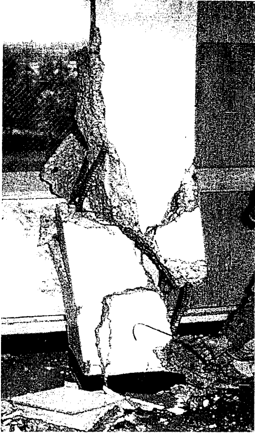
Foto-5. Falla por corte de una columna. Ausencia de estribos. Terremoto de San Fernando 1971. (EQIIS)
