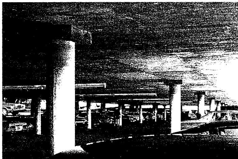
Fig. 2-8 Edificio de estacionamientos con losa plana (Flat Slab)
