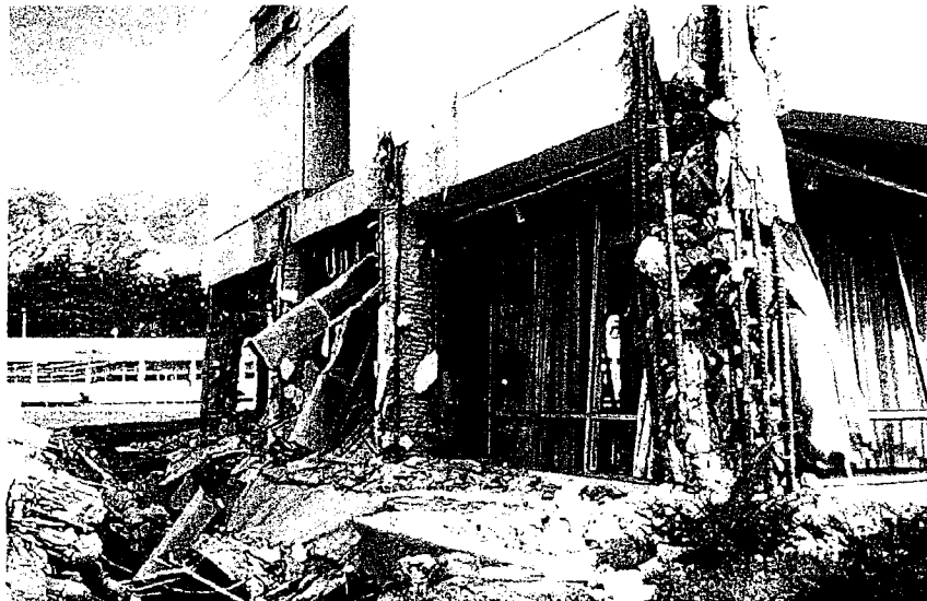
Fig. 16-11 Columnas con estribos (esquinas) y con espirales (interiores) de un mismo pórtico.
