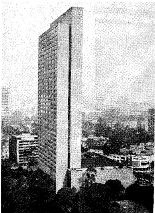
**1.1** Edificio muy esbelto con estructura de concreto reforzado. La resistencia y rigidez ante cargas laterales es proporcionada esencialmente por muros de concreto acoplados.
