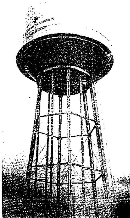
Foto 13.—Estanque metálico elevado. Santa María de Ipire, Estado Guárico, Venezuela.
