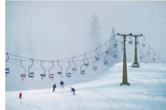
a. Cables parabólicos que soportan cargas repartidas
