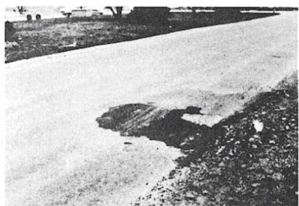
Figura B-11.b. Parchados Media-severidad.
