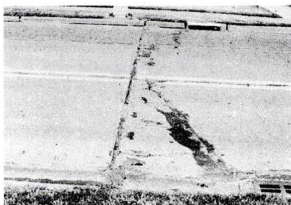
Figura C-14.b. Punzonamiento Media-severidad.
