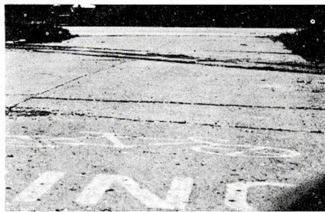
Figura C-15.b. Cruce de Ferrocarril Media-severidad.
