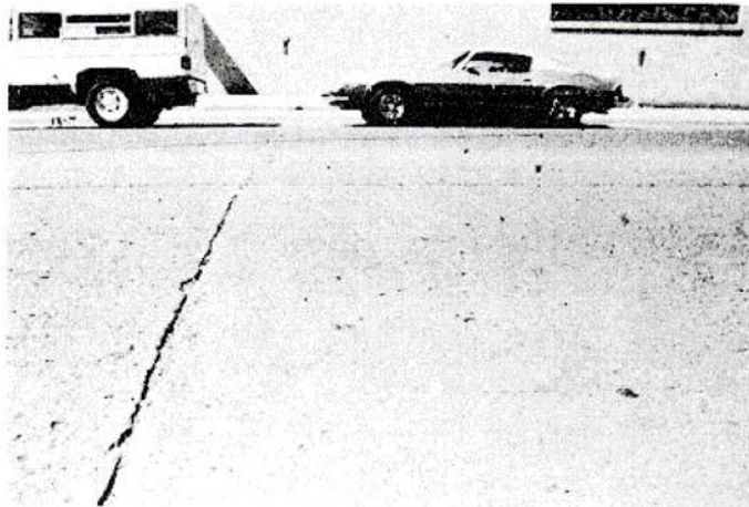
Figura C-19.a. Escamadura de Junta Baja-severidad.
