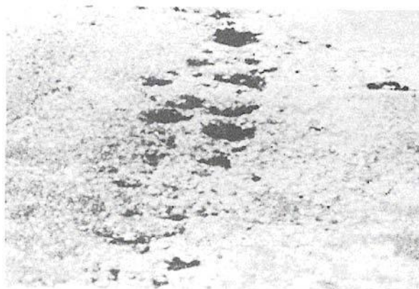
Figura B-19.c. Intemperismo Alta-severidad.
