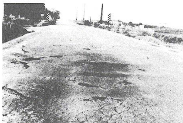
Figura B-16.b. Empellones Media-severidad.
