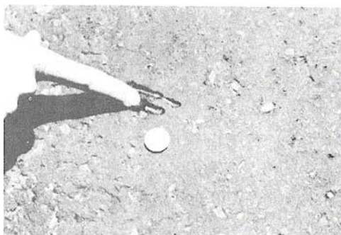
Figura B-2.b. Exudación o Sangrado Media-severidad.
