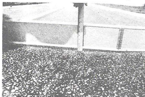
Figura B-15.b. Ruteo Media-severidad.
