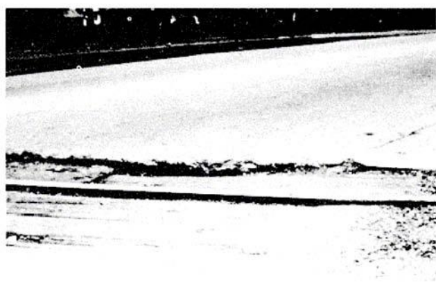
Figura C-15.c. Cruce de Ferrocarril Alta-severidad.
