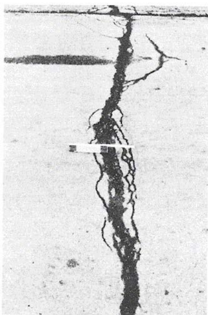
Figura B-8.c. Agrietamiento Reflejo de Juntas Alta-severidad.
