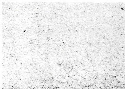
Figura C-16.a. Escamadura / Agrietamiento de Mapa / Dilapidado Baja-severidad.
