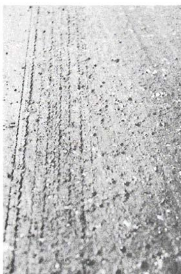
Figura B-2.c. Exudación o Sangrado Alta-severidad.
