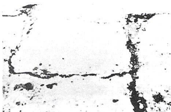
Figura C-9.c. Grande Parchado y Corte de Utilidad Alta-severidad.
