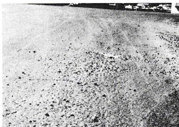
Figura B-19.b. Intemperismo Media-severidad.
