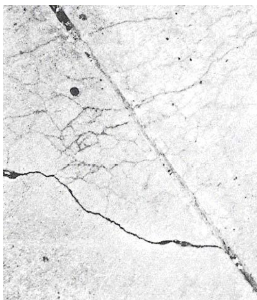
Figura C-2.a. Ruptura de Esquina Baja-severidad.
