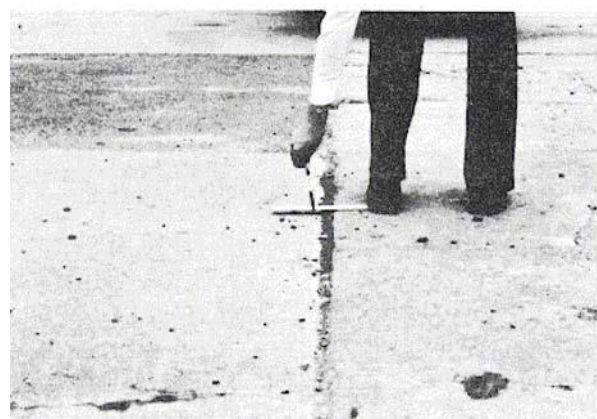
Figura C-5.b. Falla Media-severidad.
