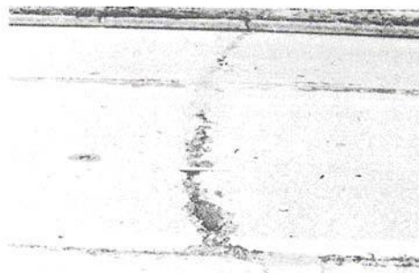
Figura C-8.c. Agrietamiento Lineal Alta-severidad.
