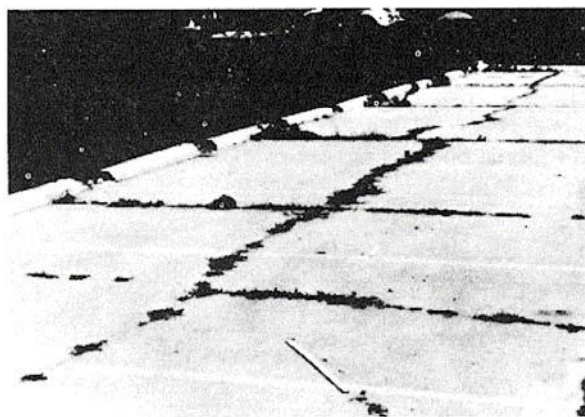
Figura C-3.b. Losa Dividida Media-severidad.
