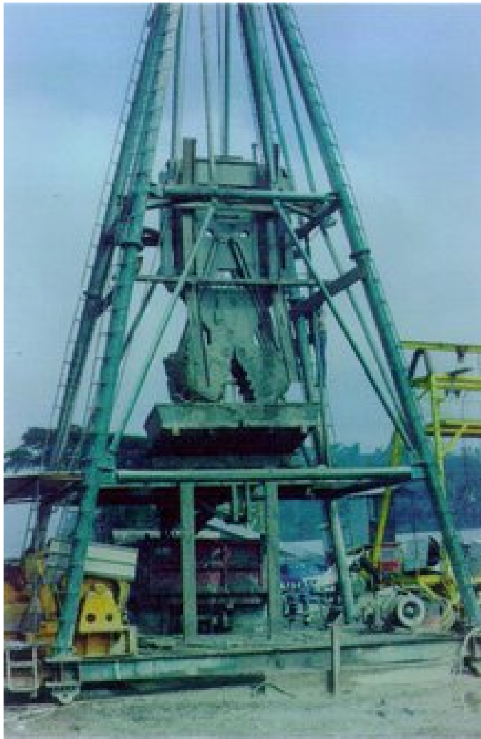
Fig. 3.51, Excavación de una zanja profunda en la presa Peñitas
