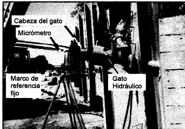
Fig. 5.46, Equipo para la medición de deformaciones durante una prueba de carga
