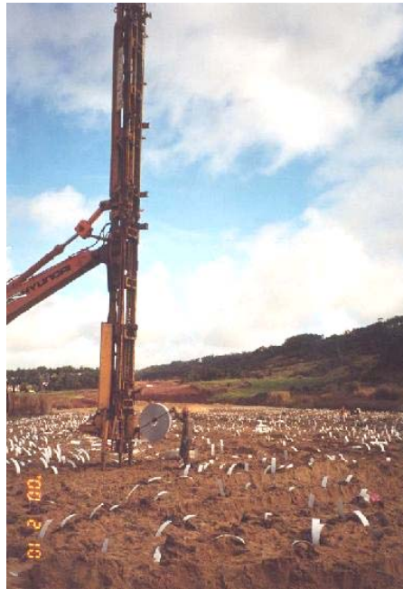
Fig. 8, Drenes “mecha” que agilizan la expulsión del agua intersticial
