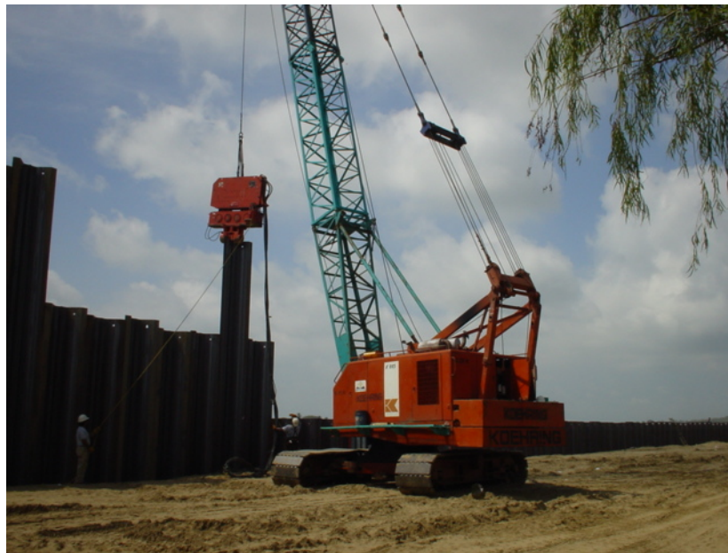
Fig. 4.46, Hincado de tablestacas
