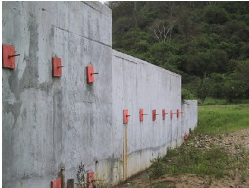
Fig. 3.126, Aspecto de los aleros anclados
