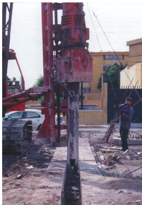
b) con brocal de concreto
