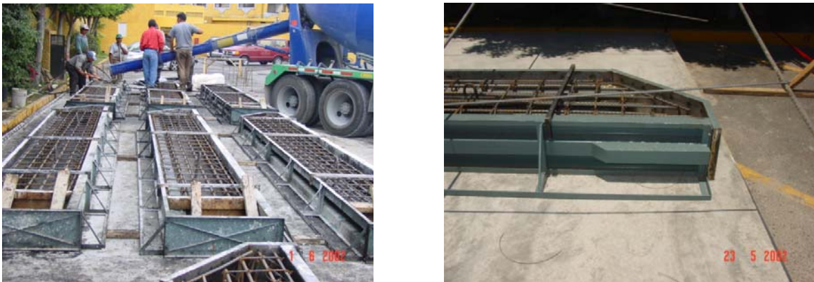
Fig. 4.8, Fabricación de tablestacas de concreto
