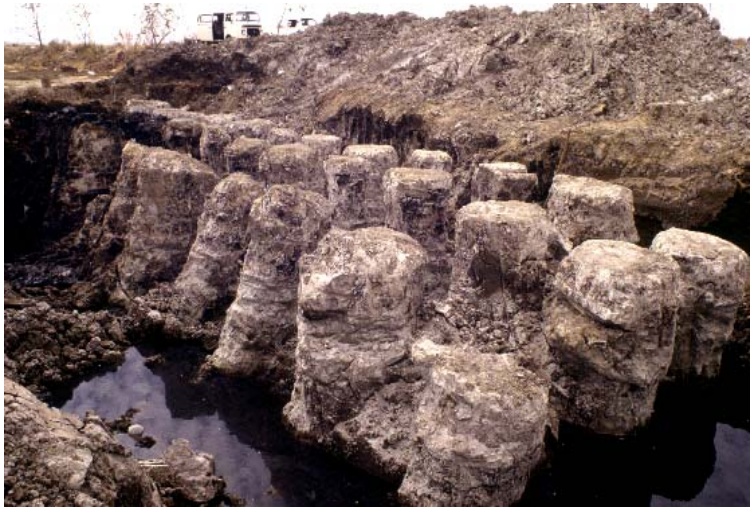
Fig. 5, Columnas de jet grouting en arcilla muy blanda
