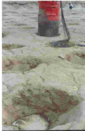
Fig. 7, Compactación en arena con ayuda de vibración
