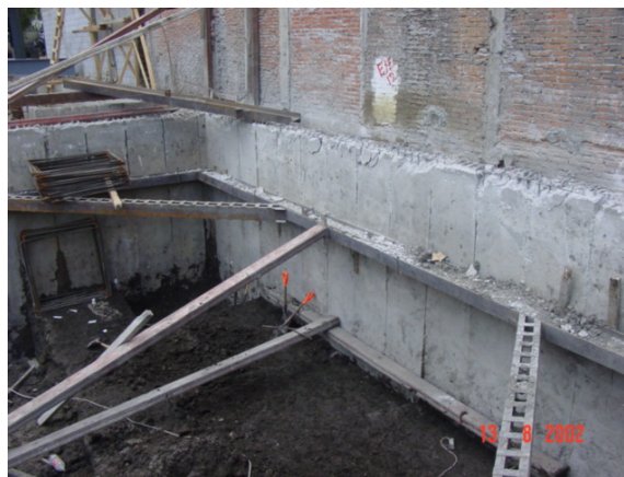
Fig. 4.42, Contención de la excavación y colindancias con tablestaca de concreto
