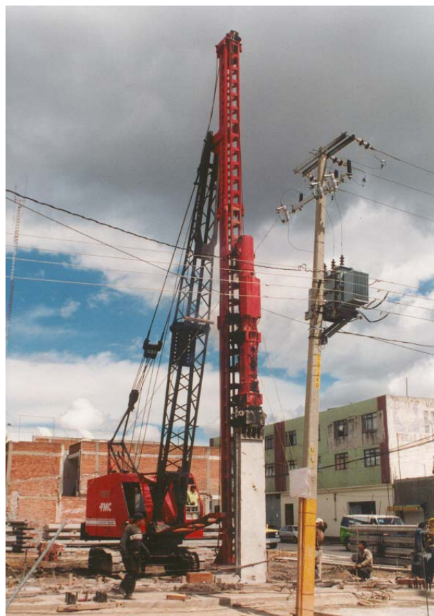
Fig. 4.14 Aspectos del hincado de tablestacas
