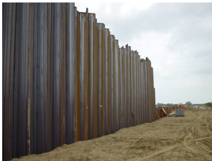
Fig.4.47, Secuencia de hincado
