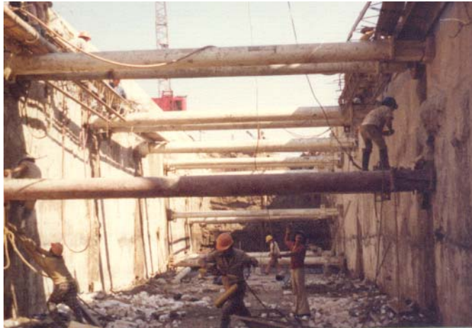
Fig. 3, Excavación en zanja para el metro de la ciudad de México, ademada con muros Milán
