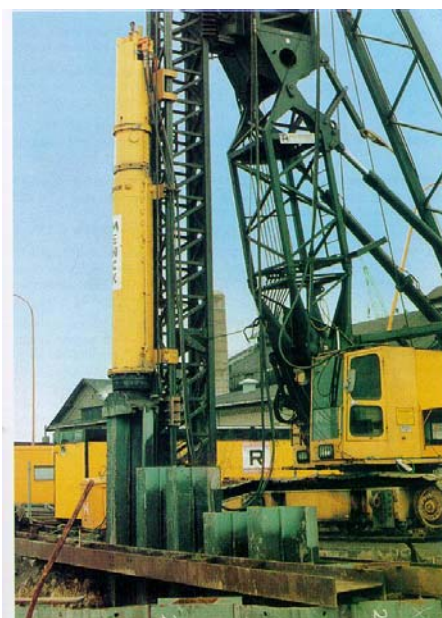
Fig. 4.17, Martillo hidráulico doble acción
