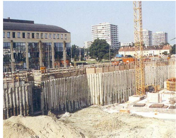
Fig. 4.29, Pilas secantes
