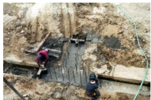
Fig. 3.123, Aspectos del proceso constructivo del muro milán en la Torre JV
