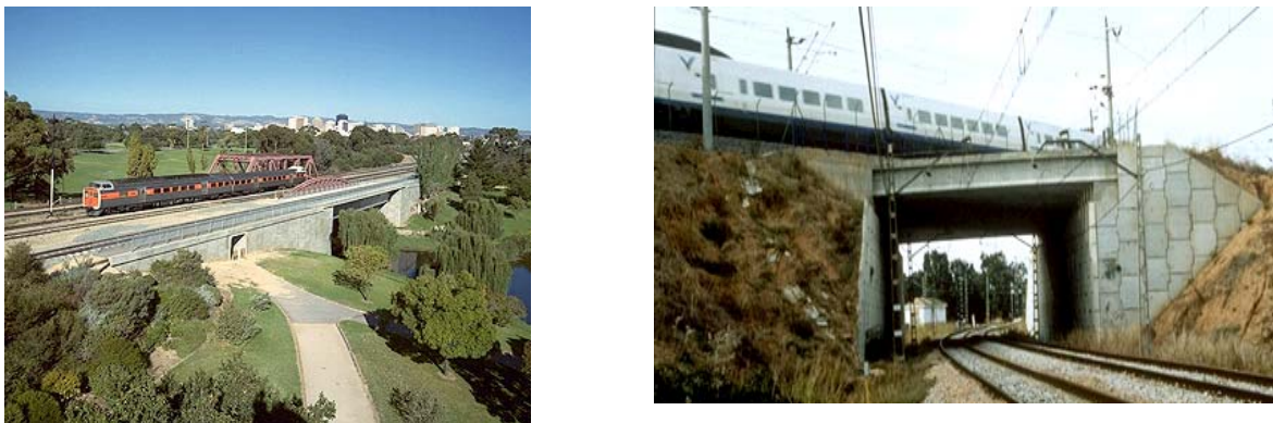
Fig 6.11, Aplicaciones de tierra armada en vías de ferrocarril
