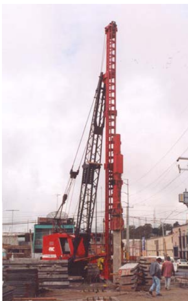
Fig 4.41, Hincado de tablestaca de concreto
