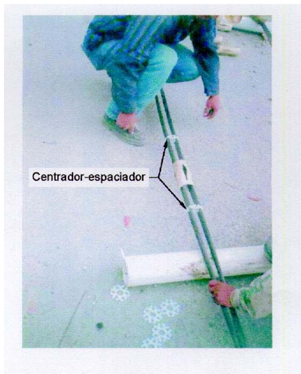
Fig. 5.17, Colocación de centradores y espaciadores
