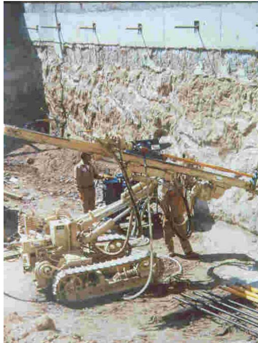
Fig. 4, Excavación anclada
