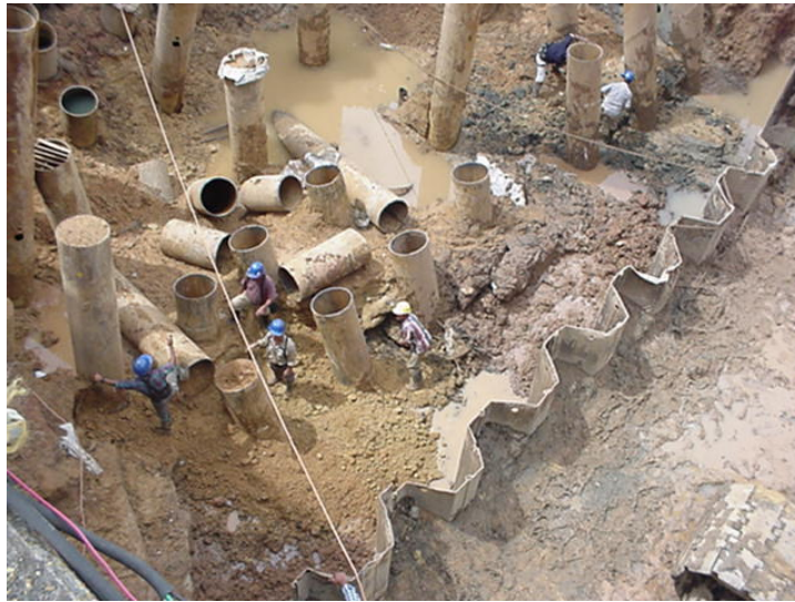
Fig. 1 Tablestaca metálica junto a pilotes tubulares
