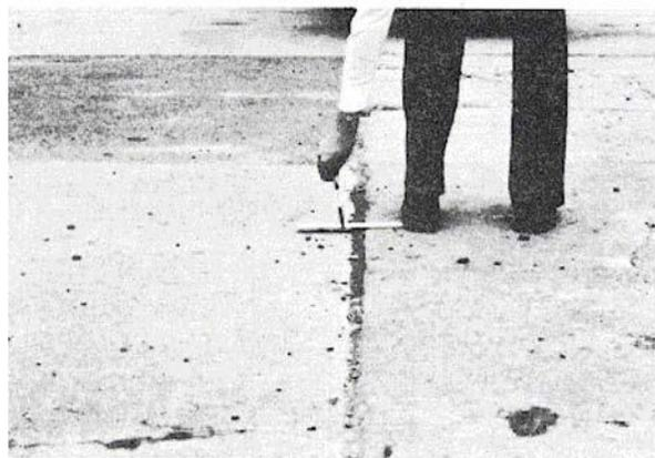
**Figura C-5.b.** Falla Media-severidad.
