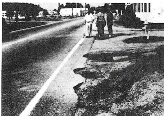
**Figura B-7.c.** Agrietamiento de Borde Alta-severidad.
