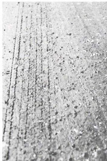
**Figura B-2.c.** Exudación o Sangrado Alta-severidad.
