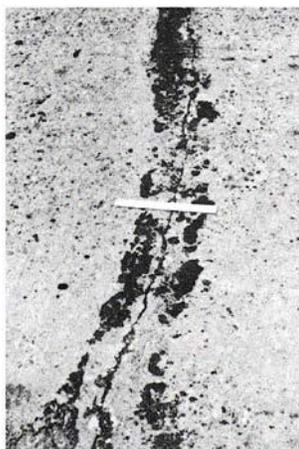
**Figura C-8.a.** Agrietamiento Lineal Baja-severidad.
