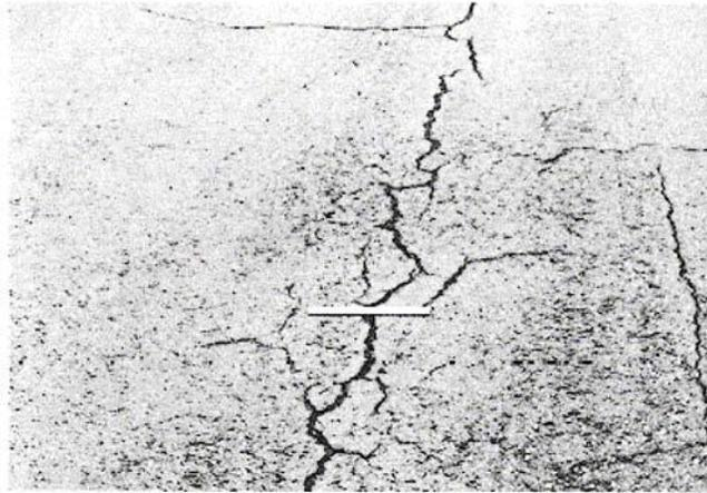
**Figura B-10.b.** Agrietamiento Longitudinal y transversal Media-severidad.
