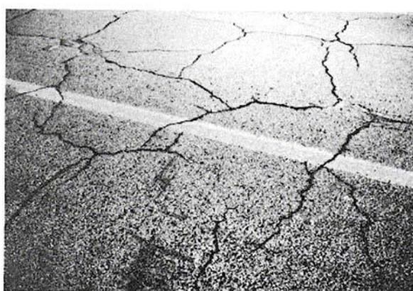
**Figura B-3.b.** Agrietamiento en bloque Media-severidad.
