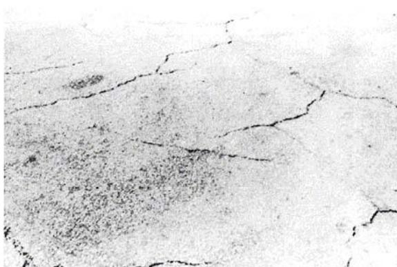
**Figura B-3.a.** Agrietamiento en bloque Baja-severidad.
