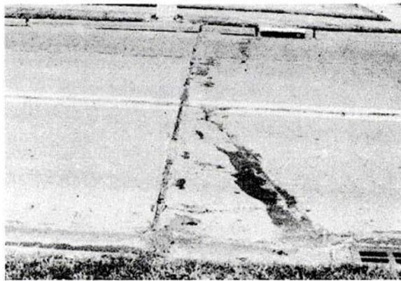
**Figura C-14.b.** Punzonamiento Media-severidad.
