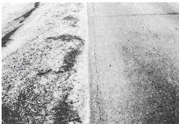
**Figura B-7.a.** Agrietamiento de Borde Baja-severidad.
