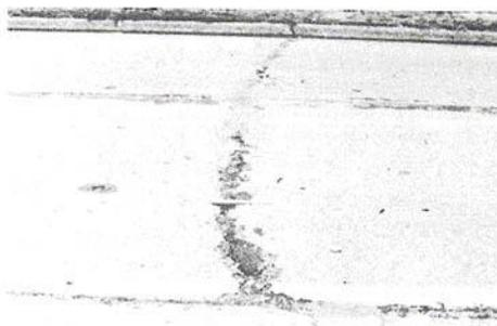
**Figura C-8.c.** Agrietamiento Lineal Alta-severidad.
