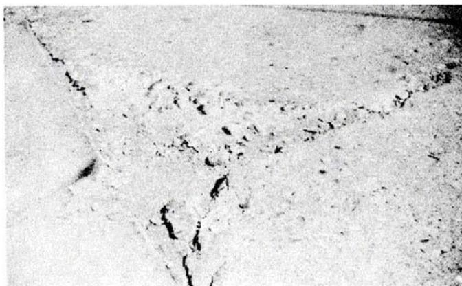
**Figura C-18.c.** Escamadura de Esquina Alta-severidad.
