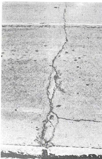
**Figura B-8.b.** Agrietamiento Reflejo de Juntas Media-severidad.
