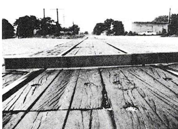
**Figura B-14.a.** Cruce de Ferrocarril Baja-severidad.
