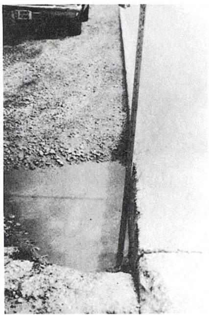
**Figura C-7.c.** Caída Externa de Vía / Hombreira Alta-severidad.
