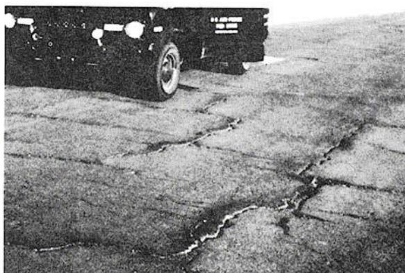
**Figura B-3.c.** Agrietamiento en bloque Alta-severidad.
