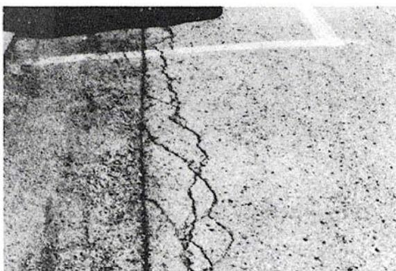
**Figura B-7.b.** Agrietamiento de Borde Media-severidad.
