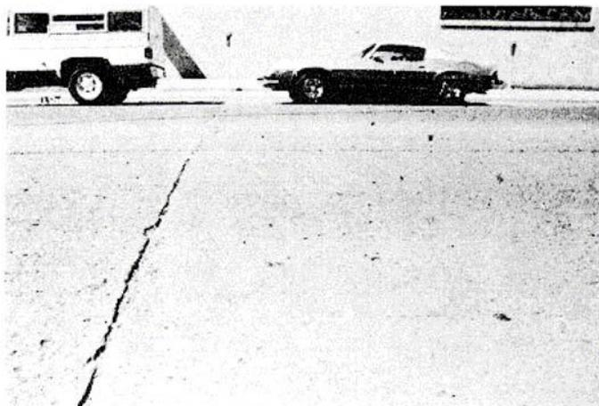
**Figura C-19.a.** Escamadura de Junta Baja-severidad.
