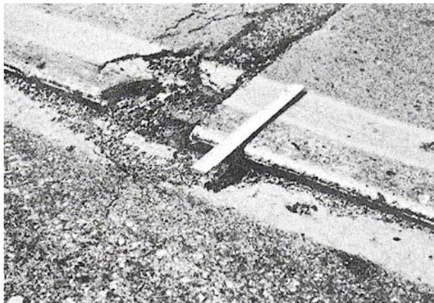
**Figura C-7.a.** Caída Externa de Vía / Hombreira Baja-severidad.
