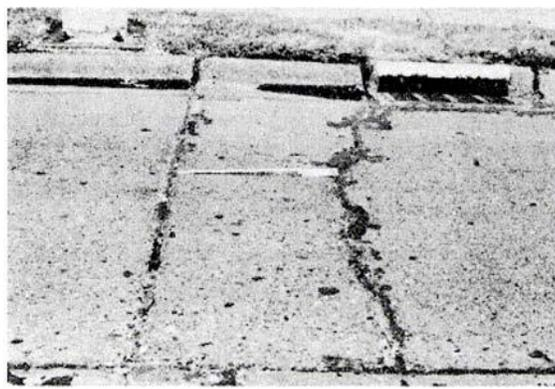
**Figura C-14.a.** Punzonamiento Baja-severidad.
