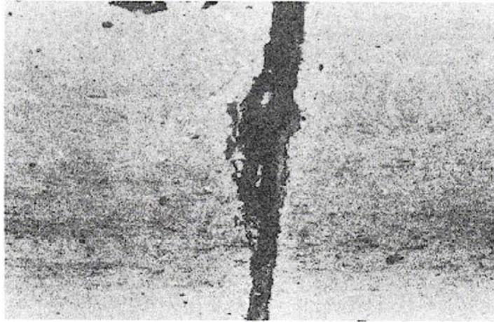
**Figura C-6.b.** Daño del Sello de Junta Media-severidad.
