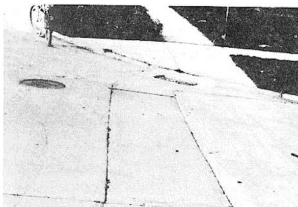
**Figura C-9.a.** Grande Parchado y Corte de Utilidad Baja-severidad.
