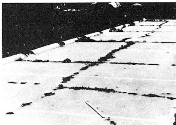
**Figura C-3.b.** Losa Dividida Media-severidad.
