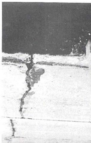
**Figura C-8.b.** Agrietamiento Lineal Media-severidad.
