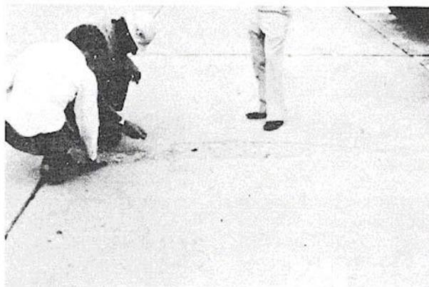
**Figura C-4.b.** Agrietamiento (“D”) de Durabilidad Media-severidad.
