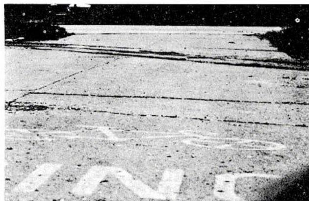
**Figura C-15.b.** Cruce de Ferrocarril Media-severidad.
