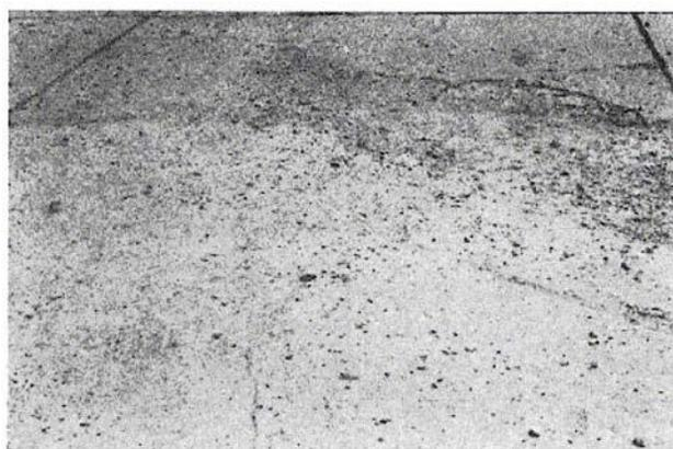
**Figura C-4.c.** Agrietamiento (“D”) de Durabilidad Alta-severidad.
