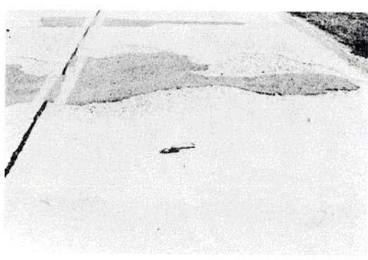
**Figura C-16.c.** Escamadura / Agrietamiento de Mapa / Dilapidado Alta-severidad.
