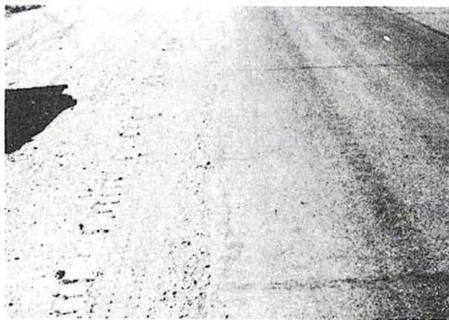
**Figura B-8.a.** Agrietamiento Reflejo de Juntas Baja-severidad.
