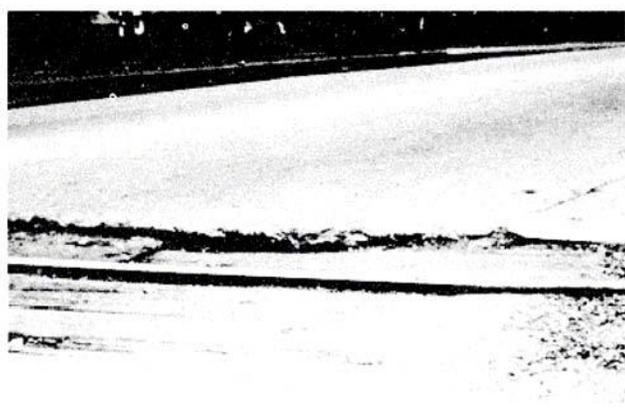
**Figura C-15.c.** Cruce de Ferrocarril Alta-severidad.
