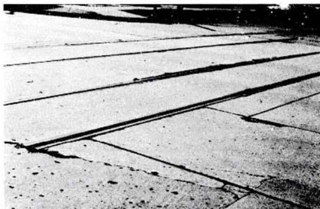
**Figura C-15.a.** Cruce de Ferrocarril Baja-severidad.
