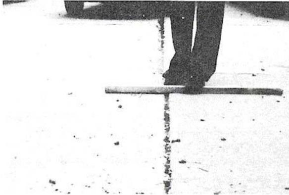
**Figura C-5.a.** Falla Baja-severidad.
