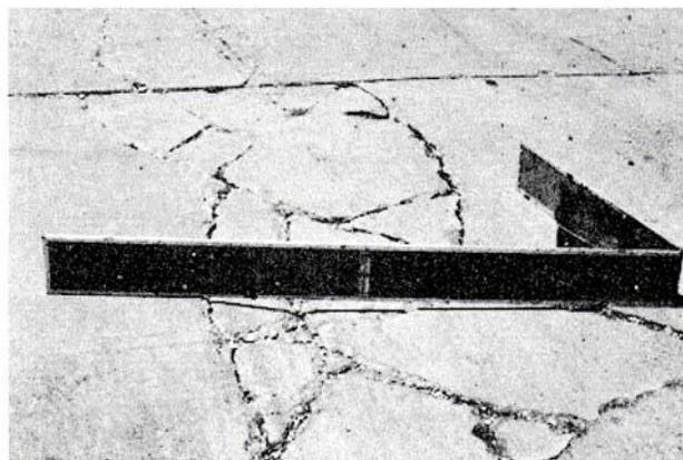
**Figura C-14.c.** Punzonamiento Alta-severidad.
