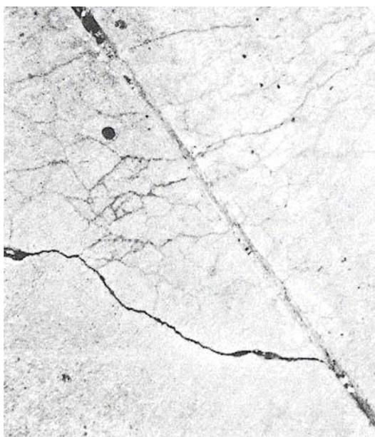
**Figura C-2.a.** Ruptura de Esquina Baja-severidad.
