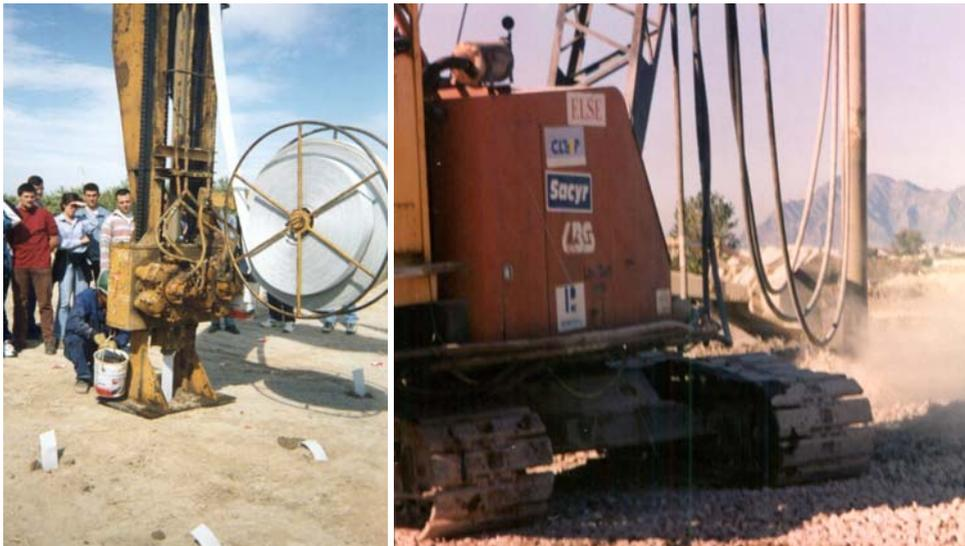
Fig. 16.9 – Sistemas de precarga (drenes de mecha) y vibrosustitución (columnas de grava)
