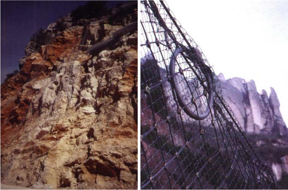
Fig. 17.6 – Talud desnudo y detalle de una malla de triple torsión
