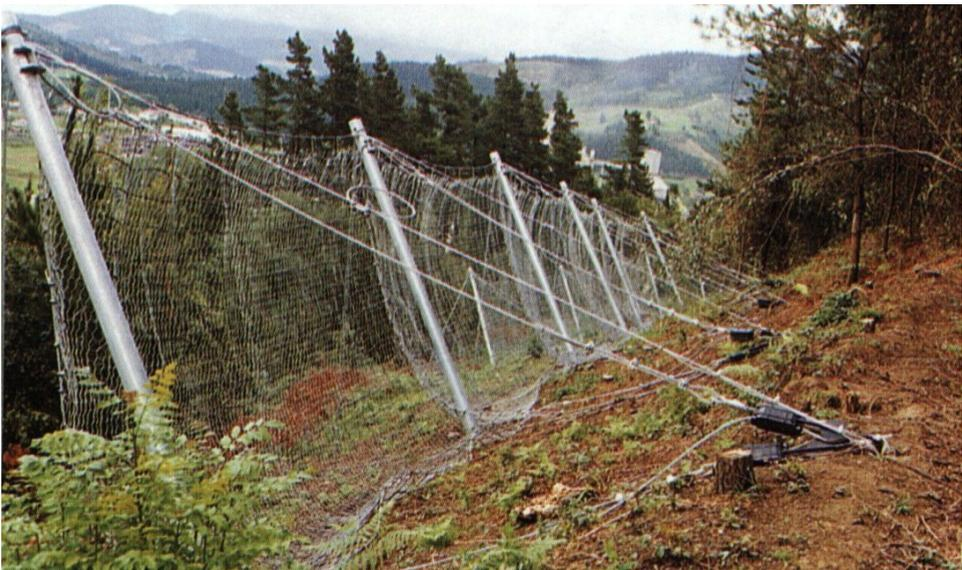
Fig. 17.7 – Barrera dinámica para la contención de fragmentos rocosos
