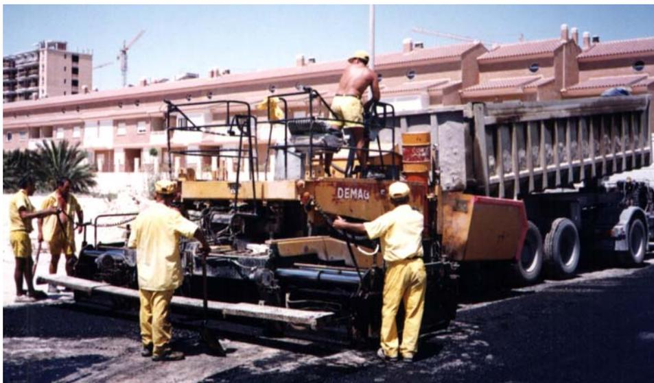
Fig. 23.7 – Proceso de carga de una extendidora
