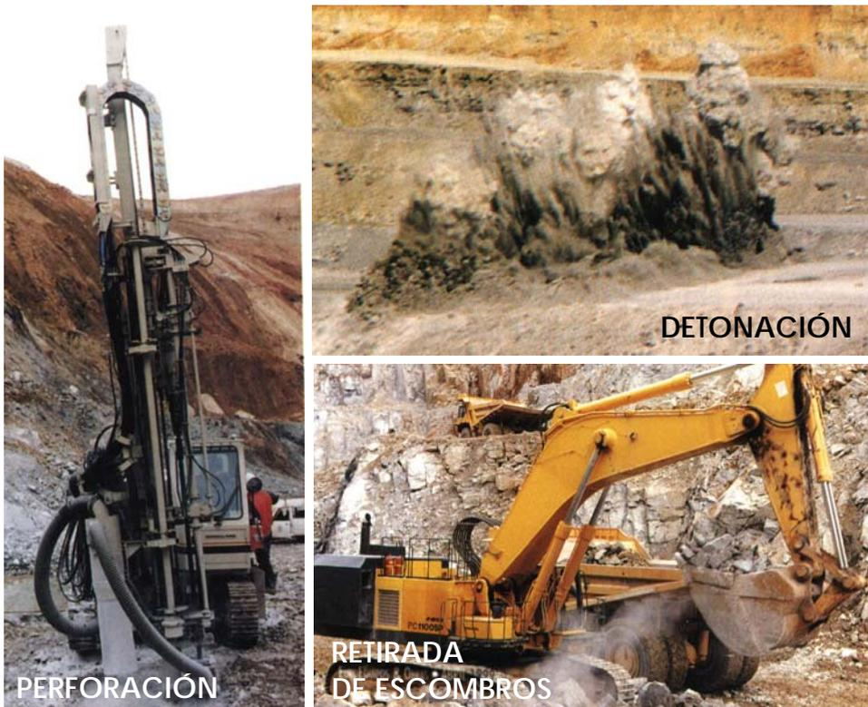
Fig. 17.9 – Diferentes fases de una voladura
