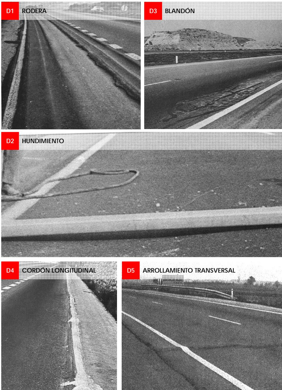
Fig. 25.1 – Deformaciones en firmes flexibles (I)
