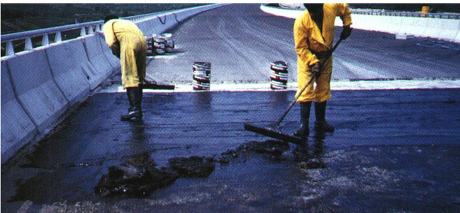
Fig. 21.1 – Extendido de una capa de mortero con betún fluidificado
