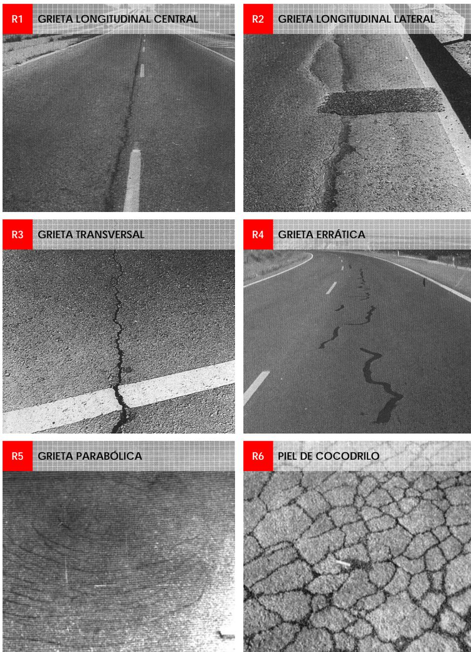
Fig. 25.3 – Roturas en firmes flexibles (I)
