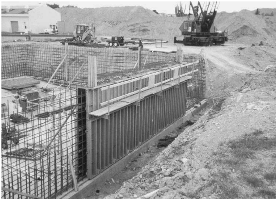
Planta de tratamiento de aguas negras de Fountain Hills , Arizona. (Cortesía de EFCO Corp.)
