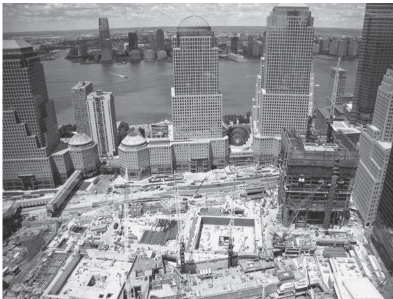
World Trade Center Uno, ciudad de Nueva York, Nueva York. (Cortesía de EFCO Corp.)
