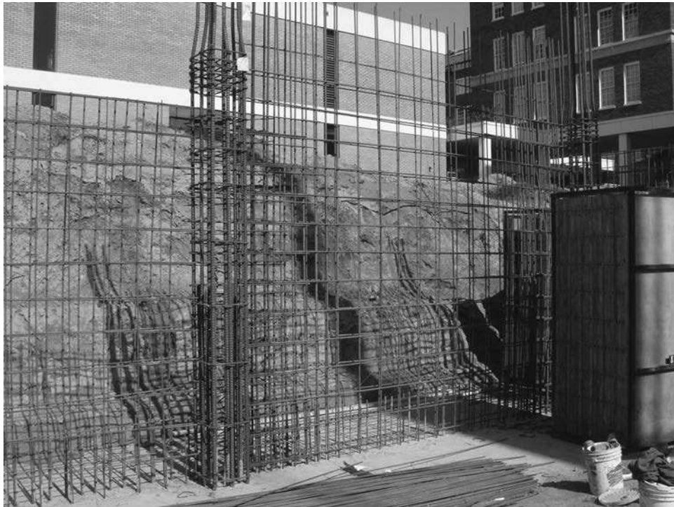
Muro de cortante con columnas extremas integradas: Anexo de Rodas (Universidad de Clemson, 2008.)
