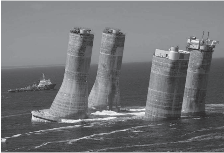
Instalación de la subestructura base por gravedad de concreto (CGBS, Concrete Gravity Base Substructure ) para la plataforma de petróleo y gas LUNA en el mar de Okhotsk, en la región de Sakhalin, Rusia. (Itar-Tass Photos/News Com.)
