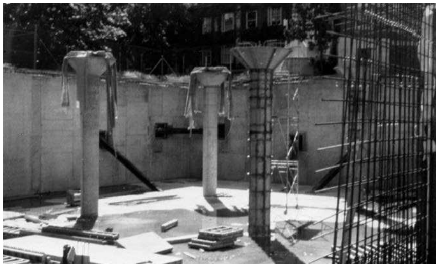
Columnas redondas. (Cortesía de EFCO Corp.)
