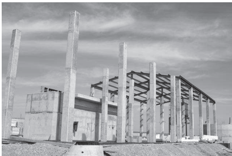
Columnas de concreto reforzado y muros de cortante que sustentan un techo de acero estructural. (©asterix0597/iStockphoto.)
