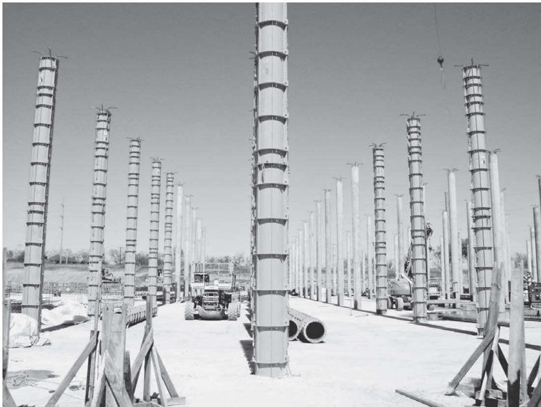
Columnas de altura variable entre 25' y 35' suministran soporte a las cubiertas de tanques para la planta de tratamiento del lado este en Sunnyvale, Texas. (Cortesía de EFCO Corp.)
