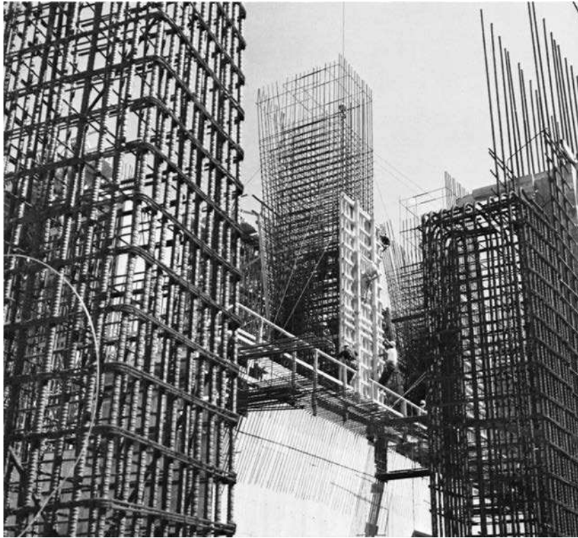
Columnas de concreto reforzado.(© Brasil2/Stockphoto.)
