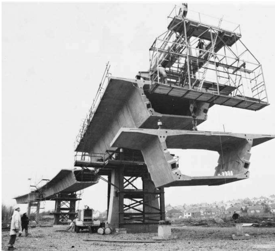
Segmentos postensados y precolados de concreto para el viaducto East Moors, en Lanbury Way, Cardiff, Gales del Sur. (Colección CC&A, cortesía de The Concrete Society.)
