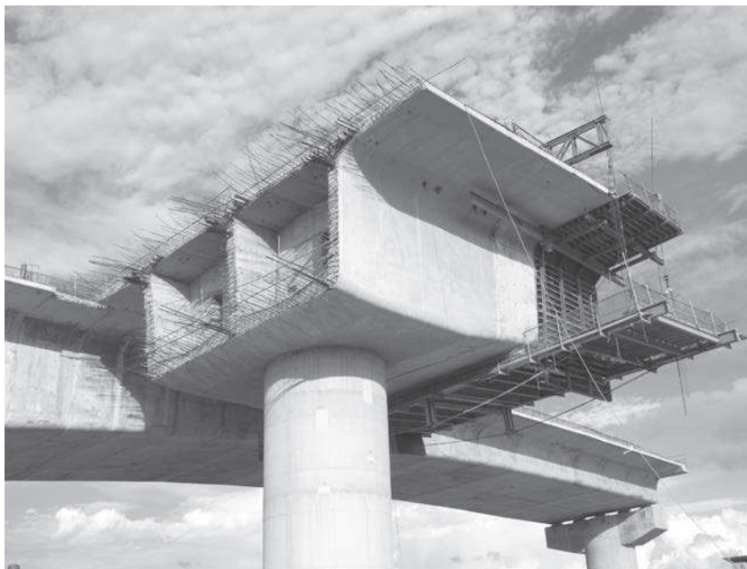
Construcción por segmentos de un puente de concreto presforzado. (© YAO MENG PENG/Stockphoto.)
