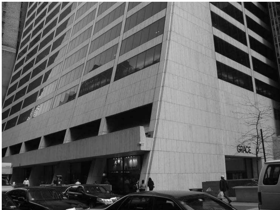
Muro de cortante con contrafuerte, edificio Grace, Nueva York, NY. (Cortesía del profesor Larry Kahn, Georgia Institute of Technology.)
