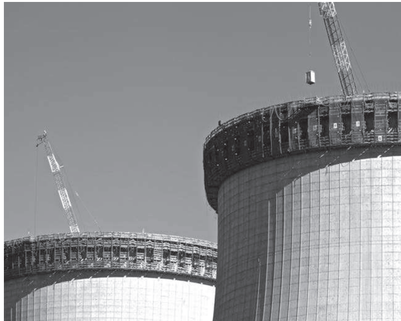
Construcción de una planta de energía nuclear. (©Todd Castor/iStockphoto.)
