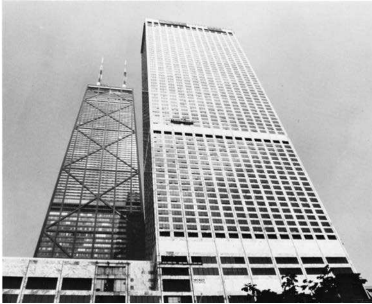
Water Tower Place, Chicago, Illinois, el edificio más alto de concreto reforzado en Estados Unidos (74 niveles, 859 pies). (Cortesía de Dayton Superior.)
