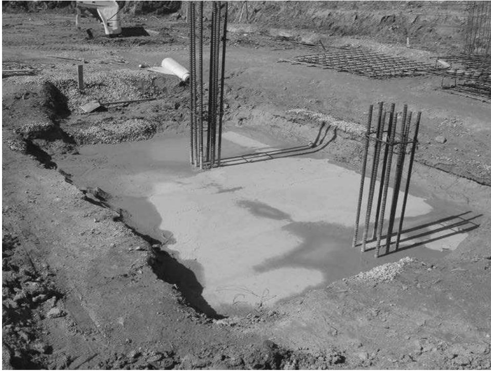
Zapata combinada (dos columnas) después de haber colado el concreto de la zapata que muestra el refuerzo de la columna listo para el empalme, anexo de Rodas: Clemson University, 2008.
