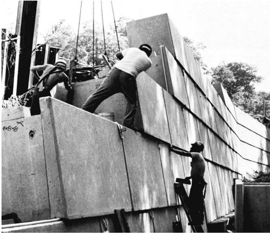
Muro de retención para el ferrocarril Long Island, Huntington, Nueva York. Construido con módulos interconectados de concreto reforzado precolados. (Cortesía de Doublewal-División de United Concrete.)
