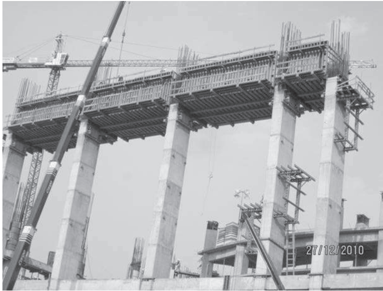
Megaconstrucción con vigas de concreto a 100' arriba de la rasante. Arena Ciudad de México, Ciudad de México, México. (Cortesía de EFCO Corp.)
