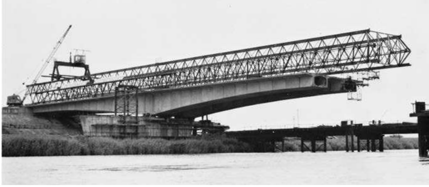
Puente construido con segmentos de concreto presforzado sobre el Río Trent, cerca de Scunthorpe, Lincolnshire, Inglaterra. (Cortesía de Cement and Concrete Association.)
