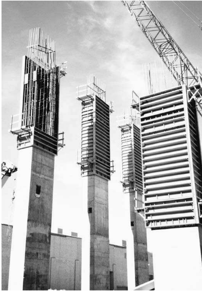
Centro de Convenciones de Richmond, Richmond, Virginia. Observe los cambios del tamaño de columna. (Cortesía de EFCO Corp.)
