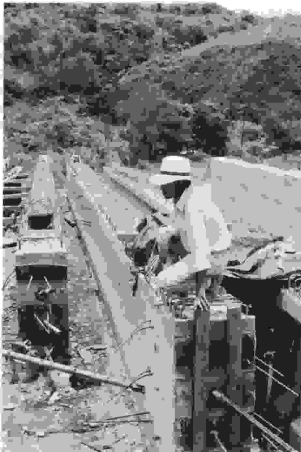
FIGURA 18.21 Vigas prefabricadas y diseñadas para estructura de puente.
