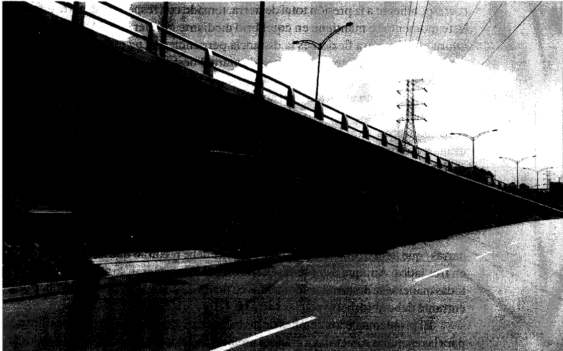
FIGURA 17.10 Muro de contención prefabricado con altura variable.
