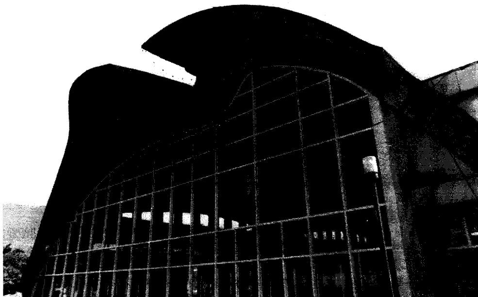
FIGURA 1.7 Casarón esférico en Medellín, Colombia. Las superficies de borde en voladizo proporcionan rigidez al domo lateral.
