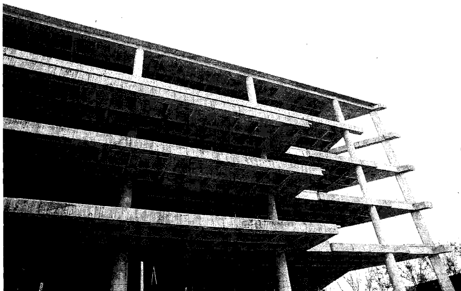
FIGURA 1.2 Sistema de entresijo de viguetas en 2 direcciones apoyado sobre vigas monolíticas de concreto y riostra transversal en la esquina.
