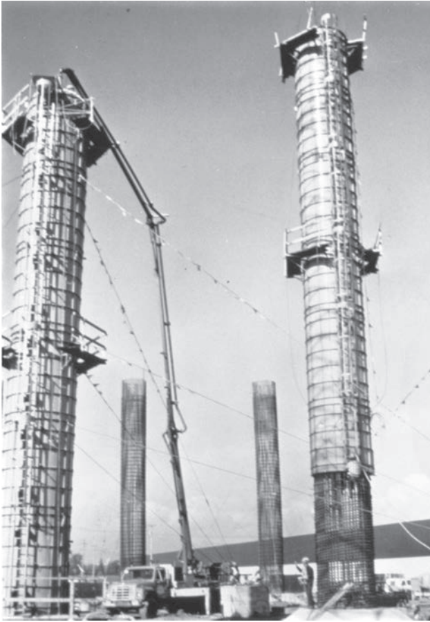
Columnas redondas zunchadas. (Cortesía de Economy Forms Corporation.)
