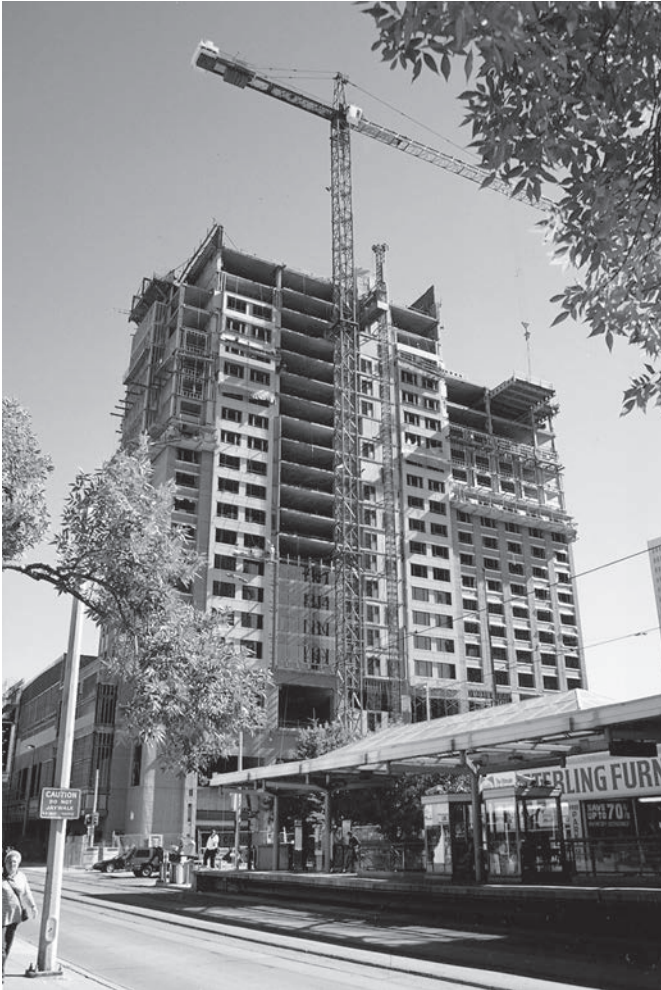
Edificio de concreto reforzado en Calgary, Canadá. (Cortesía de EFCO Corp.)
