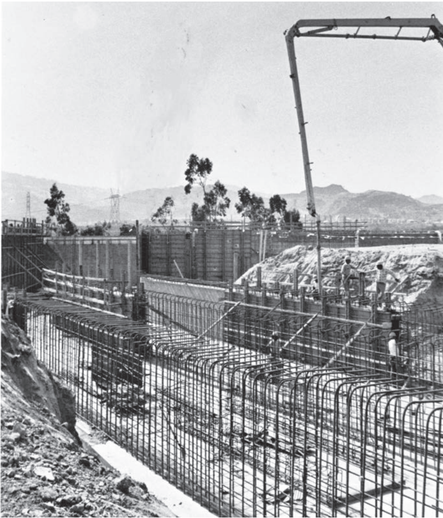
Proyecto hidráulico en el Condado de Los Ángeles. (Cortesía de The Burke Company.)
