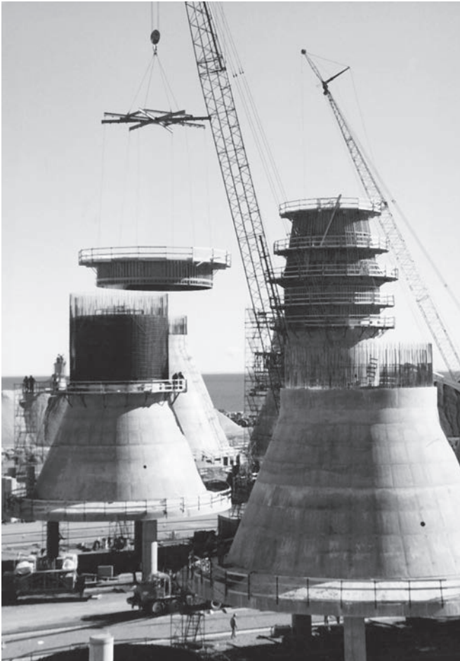
Bases de pilar para el puente entre la Isla del Príncipe Eduardo y la tierra firme de New Brunswick y Nova Scotia, Canadá. (Cortesía de Economy Forms Corporation.)
