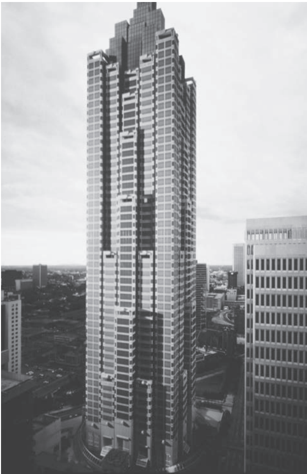
El One Peachtree Center en Atlanta, Georgia, tiene 854 pies de alto, construido para los Juegos Olímpicos de 1996. (Cortesía de Portland Cement Association.)
