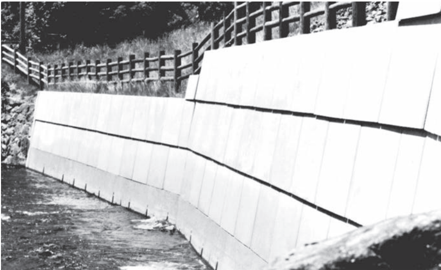
Muro de retención para el Cuerpo de Ingenieros del Ejército de Estados Unidos, Colchester, Connecticut. Construido con módulos interconectados prefabricados de concreto reforzado. (Cortesía de Doublewal Corporation.)
