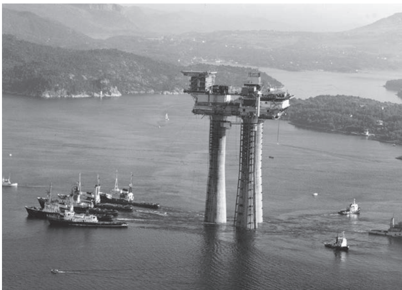
Remolque de dos cilindros huecos de concreto reforzado, cada uno de 65 pies de diámetro y 185 pies de altura, en el Mar del Norte, como parte de una plataforma perforadora de petróleo. (Cortesía de United Nations, J. Moss.)
