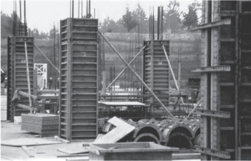
Cimbras de columnas. (Cortesía de Economy Forms Corporation.)
