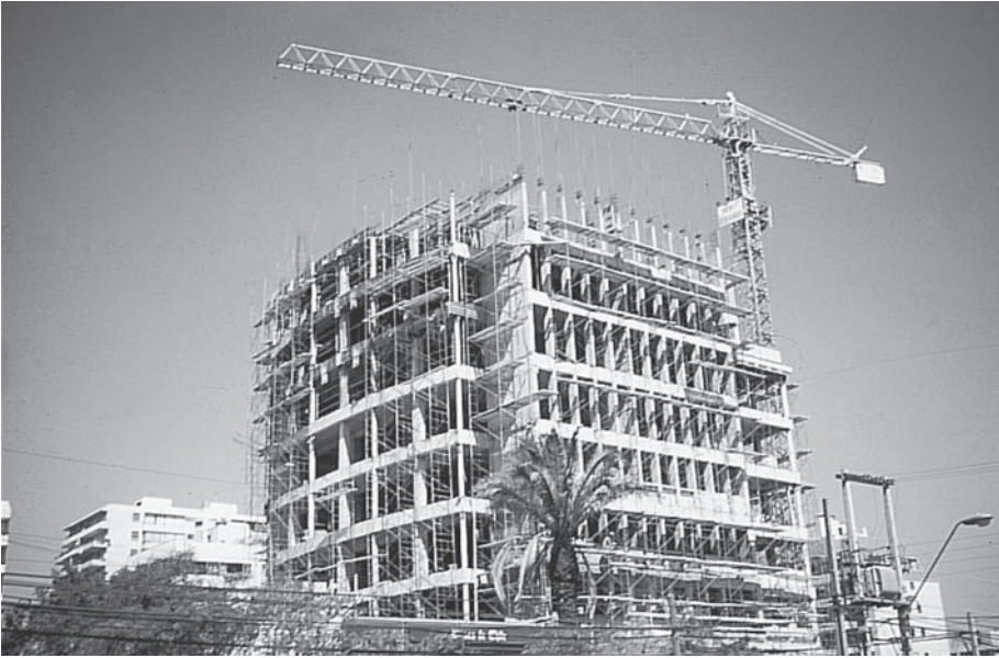
La Torre Apoquindo de 16 niveles, en Santiago, Chile. (Cortesía de Economy Forms Corporation.)
