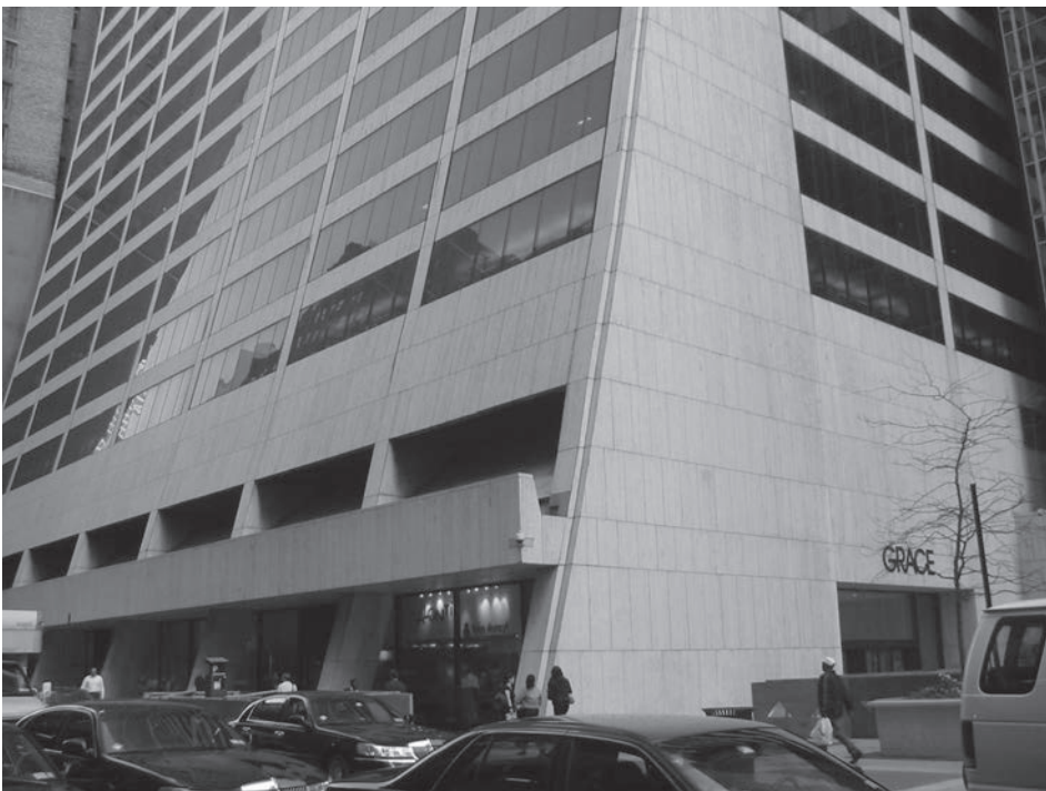
Muro de cortante con contrafuerte, Hilton de Nueva York, Nueva York, NY. (Cortesía del Prof. Larry Kahn, Georgia Institute of Technology.)
