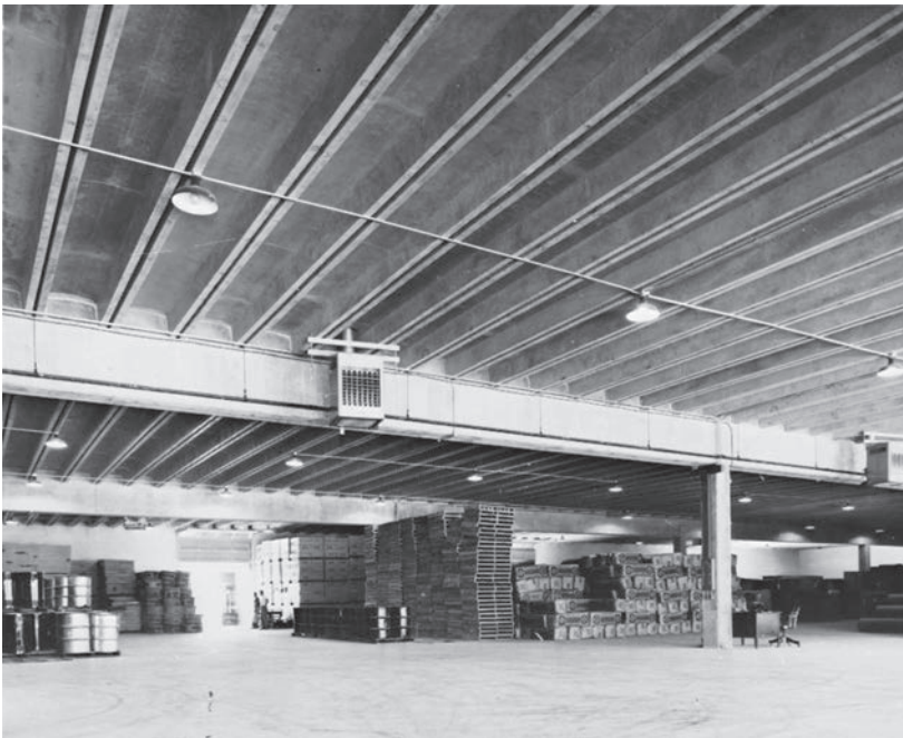
Canales de concreto presfuerzo, John A. Denies Son Company, Almacén # 4, Memphis, Tennessee. (Cortesía de Master Builders.)
