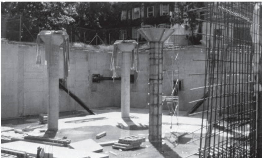
Columnas redondas. (Cortesía de Economy Forms Corporation.)
