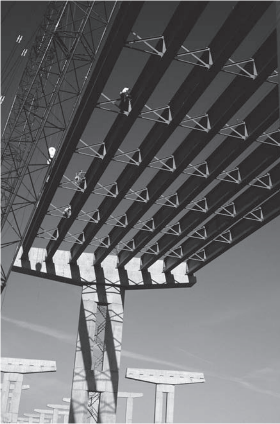
Puente de pilares y cubierta. (PhotoDisc, Inc./Getty Images.)
