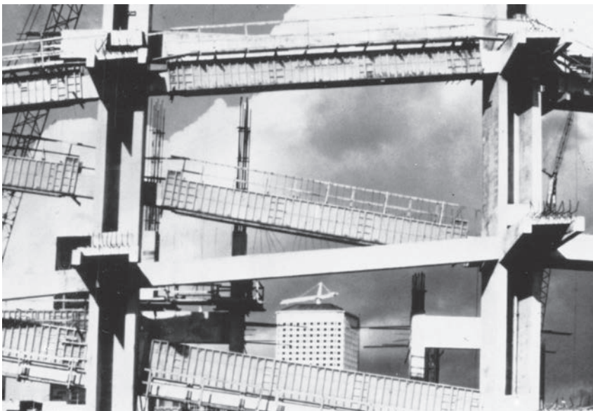
Construcción del Kingdome, Seattle, Washington. (Cortesía de EFCO Corp.)
