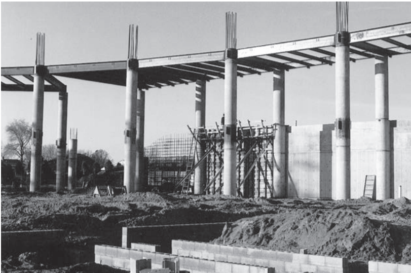
Iglesia de la Primera Asamblea en Wyoming, MI. (Cortesía de Veneklasen Concrete Construction Co.)
