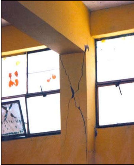
Figura 7.31 Columna corta dentro de edificación escolar .
