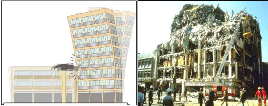
Figura 7.33 Martilleo entre edificios colindantes, México 1985
