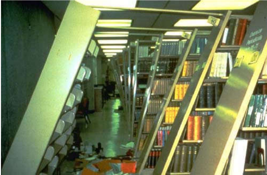
Figura 7.35 Interior de la biblioteca de la Universidad Estatal de California, terremoto de 1987 Whittier Narrows. Los estantes se inclinaron transversal y longitudinalmente, la gran masa que soportan requiere manejo ingenieril en los apoyos.
