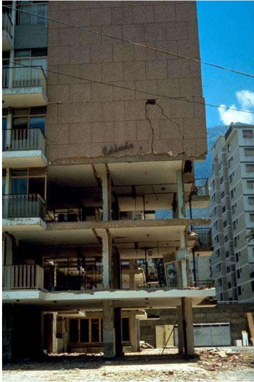
Figura 7.36 La tabiquería del segundo, tercer y cuarto piso fue expulsada de la estructura aporricada que se muestra apuntalada en la imagen. Terremoto de Caracas 1967, Venezuela.
