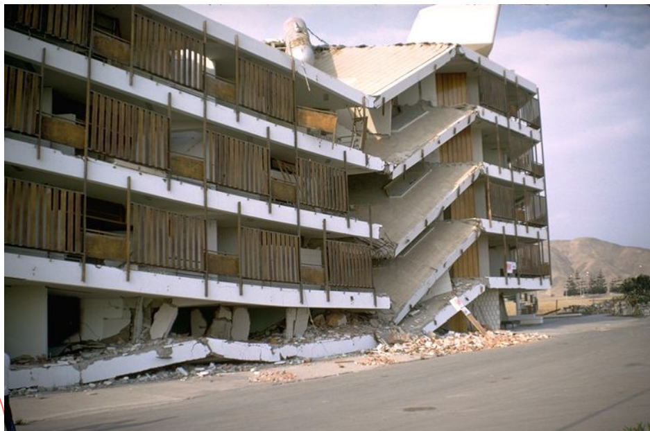
Figura 2.3 Colapso de un edificio de 5 pisos en el balneario de Santa María, al Sur de Lima, setiembre de 1968
