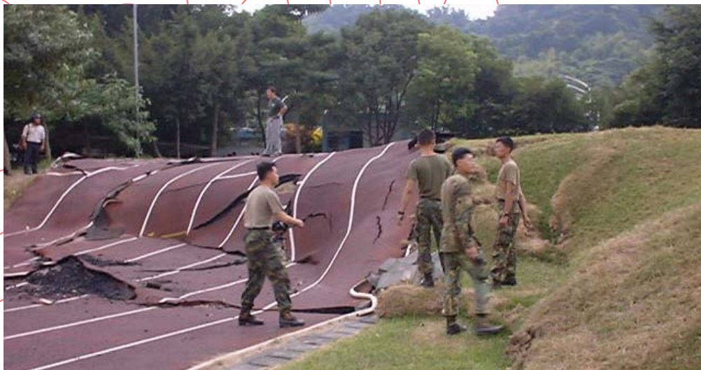
Figura 2.5 Ruptura en superficie que atraviesa la pista atlética de la escuela de Kuangfu, terremoto de Chi-Chi, 1999, Taiwán
