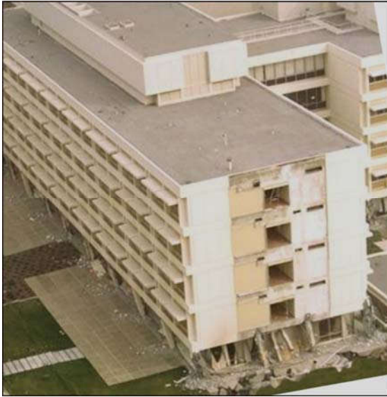
Figura 7.22 Daño severo causado por piso blando en el Medical Treatment Building del Hospital Olive View. Los Ángeles, EEUU, 1971.
