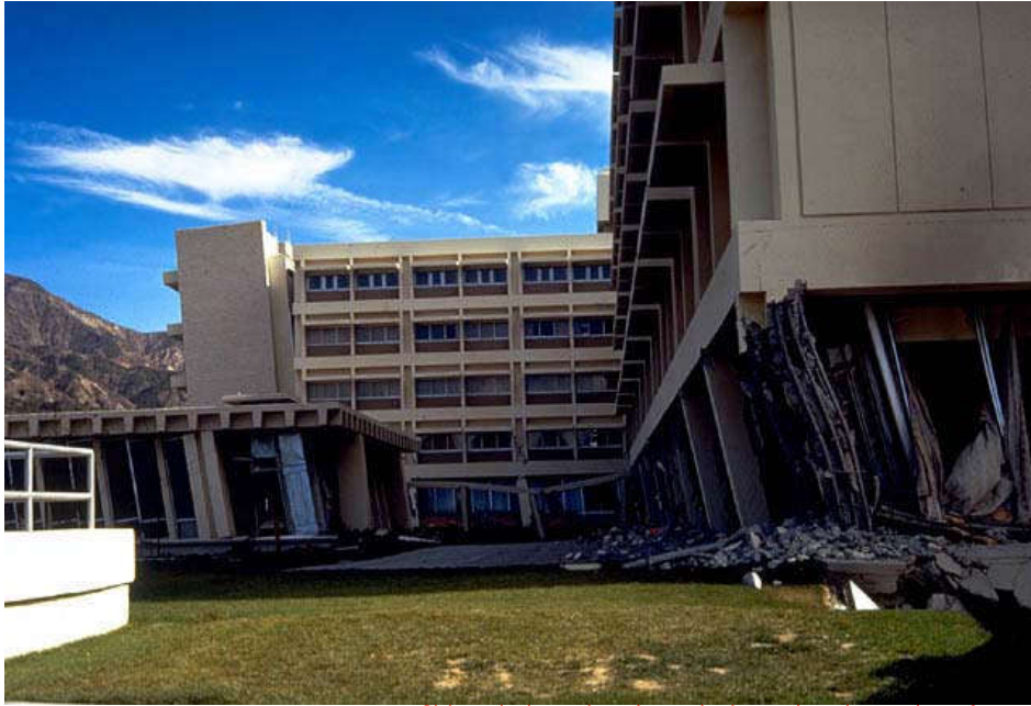
Figura 7.20 Acercamiento del daño severo ocasionado en el Hospital Olive View.
