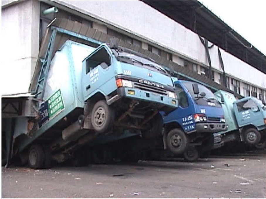
Figura 7.40 estacionamiento de camiones colapsado
