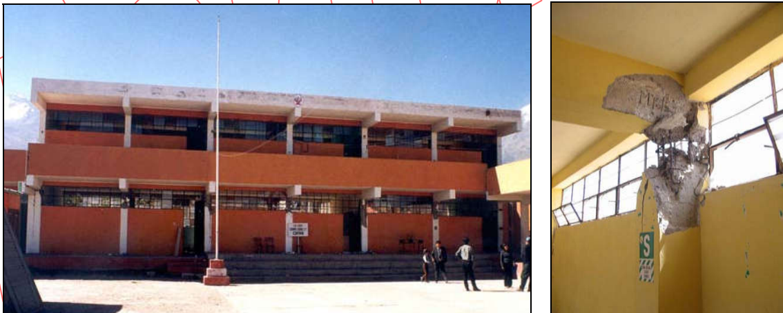
Figura 7.30 Edificación escolar en el sur del Perú. Típico problema de columna corta
