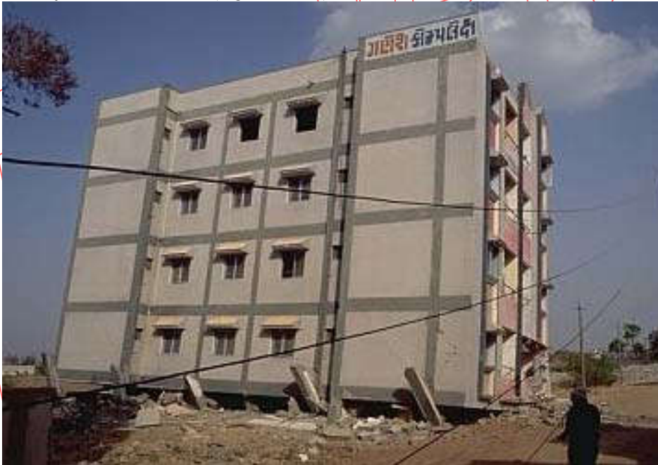
Figura 7.23 Colapso del primer piso (piso blando). Bhuj, India 2001. (Cortesía de Kerstin Lang)
