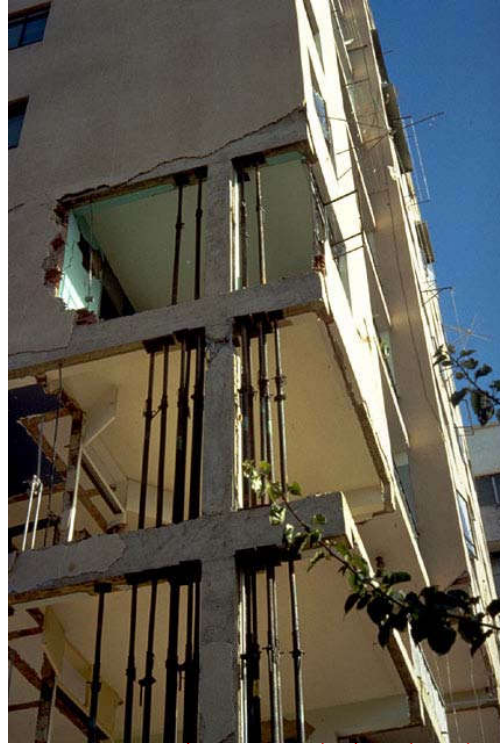
Figura 7.36 La tabiquería del segundo, tercer y cuarto piso fue expulsada de la estructura aporricada que se muestra apuntalada en la imagen. Terremoto de Caracas 1967, Venezuela.
