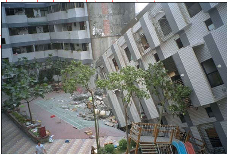
Figura 4.2 Colapso de un edificio de vivienda en el terremoto de Chi-Chi, Taiwan, 1999.
