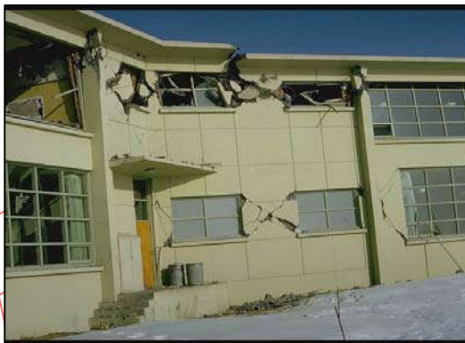
Figura 7.14 Diafragma roto en una escuela con diafragma en V durante el terremoto de Alaska, EEUU, 1964.
