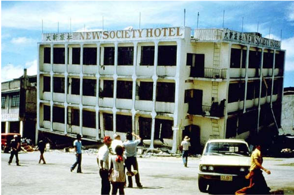
Figura 7.17 Colapso en edificio en esquina debido a excentricidad de rigidez. Cotobato 1976, Filipinas.
