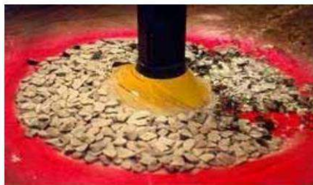
Figura 10.15 Protección de un pilar (Confederation Bridge).
