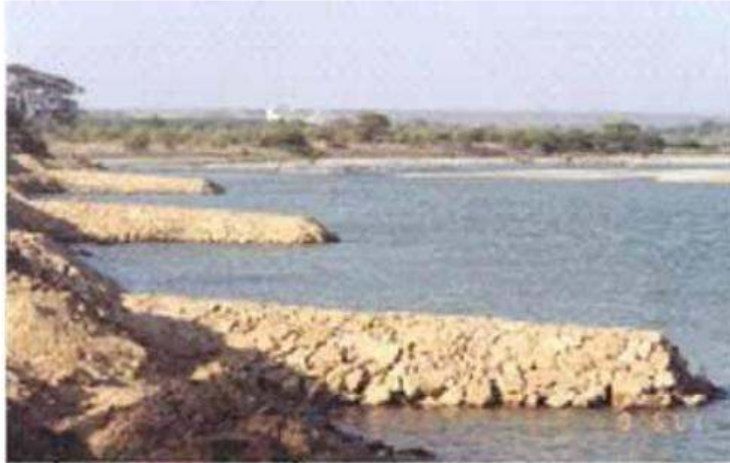
Figura N° 9.1 Espigones en el río Chira.
