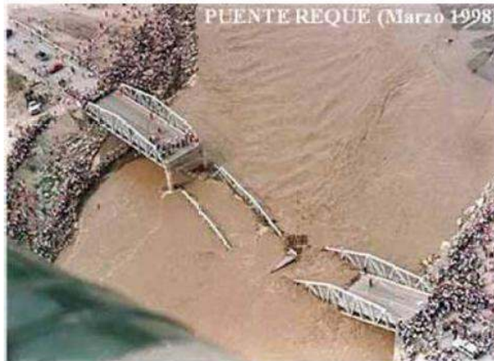
Figura N° 10.4 Caída del puente sobre el río Reque (1998).
