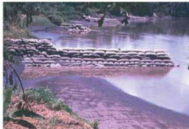
Figura N° 9.7 Diversos elementos para formar espigones (Bendegom L. Van, Zanen A. y otros)
