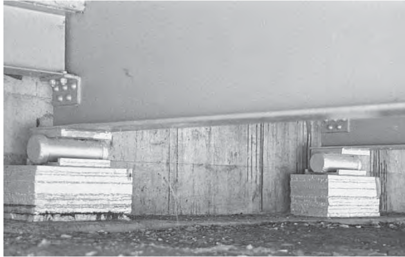
FIG. 3.4 Apoyo de patín Cortesía del Departamento de Transporte de Illinois
