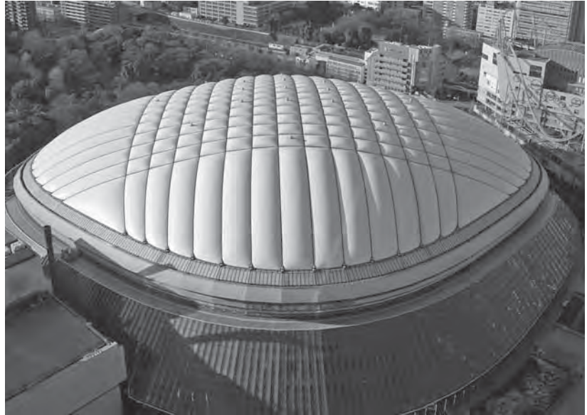
FIG. 1.6 Techo de lona (membrana) del Domo de Tokyo tensada por aire a presión desde el interior del estadio. © Gavin Hellier / Alamy
