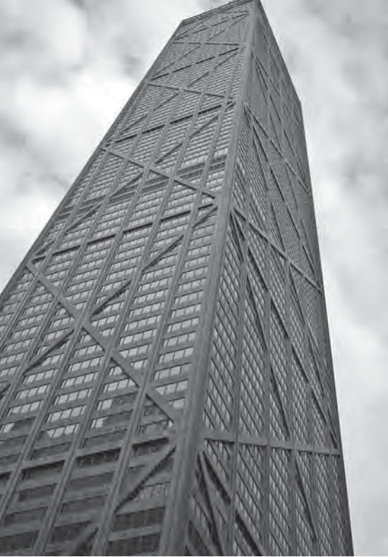
El edificio John Hancock en Chicago, con riostras en cruz en su cara exterior que reducen el movimiento horizontal causado por fuertes vientos.
