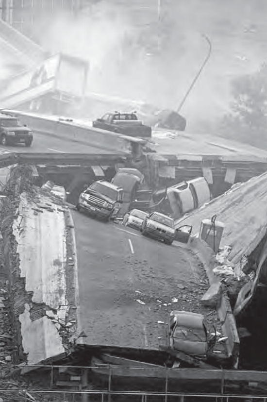
Colapso del Puente Interestatal 35 W en Minnesota (2007). AP Photo/Pioneer Press, Brandi Jade Thomas
