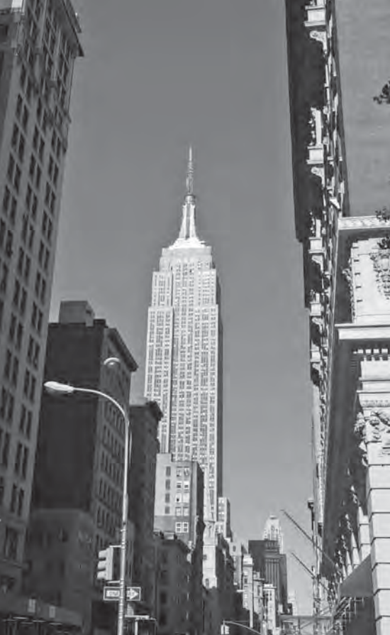
Edificio Empire State, New York
