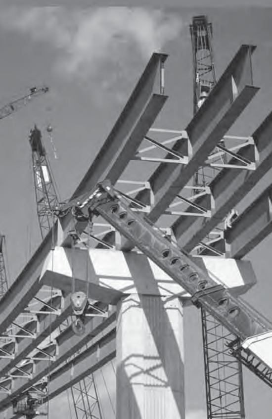
Construcción de un puente de autopista
