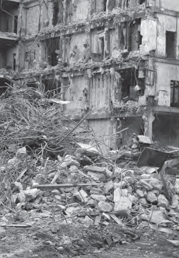
Edificio dañado por un sismo Ints Vikmanis/Shutterstock.com
