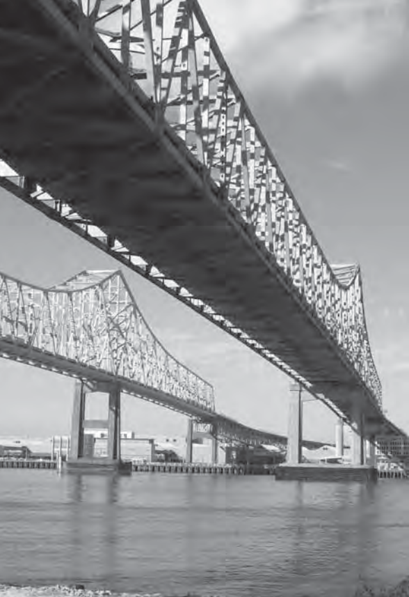
Puentes de armadura
