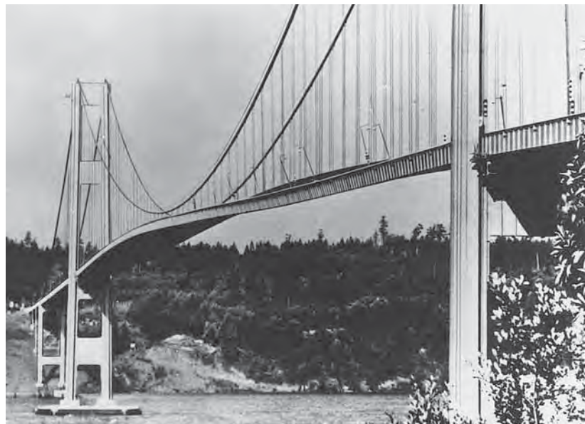
FIG. 1.5 Puente estrecho de Tacoma oscilando antes de colapsar en 1940. Instituto Smithsonian Foto 72-787, División del Trabajo y la Industria, Museo Nacional de Historia Americana, Instituto Smithsonian
