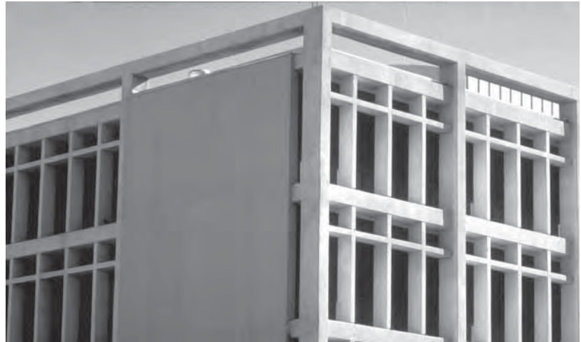
FIG. 1.12 El muro de cortante en un lado del edificio fue diseñado para resistir cargas laterales debidas al viento y a sismos.
