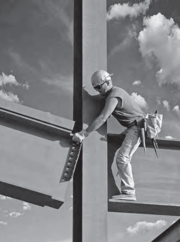
Vigas de acero
