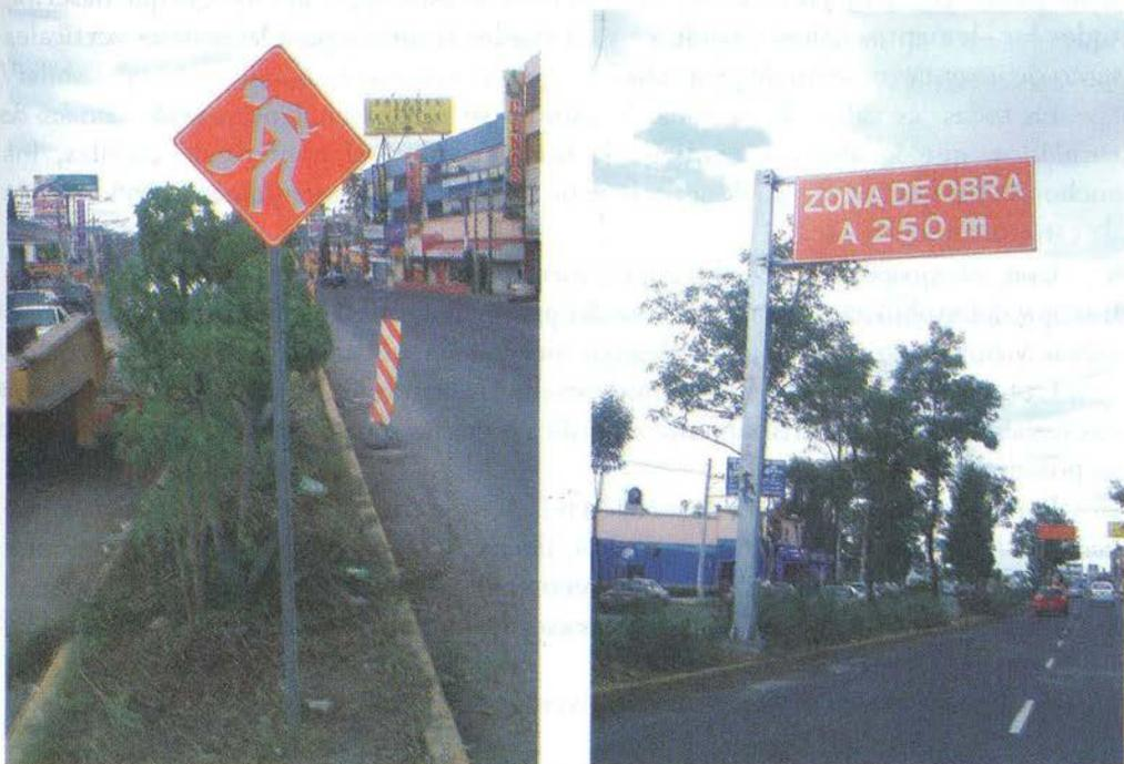
**Figura 7.16** Dispositivos para protección en obras
